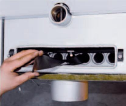
Die mitgelieferten Turbulatoren werden bei Bedarf, wie in der Abbildung ersichtlich, in die Abgaswärmetauscherrohre eingesetzt.
