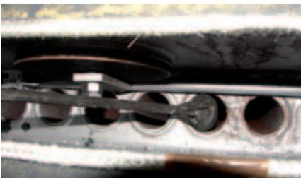
Reinigen Sie den Wärmetauscher mit dem Rundschraper.
