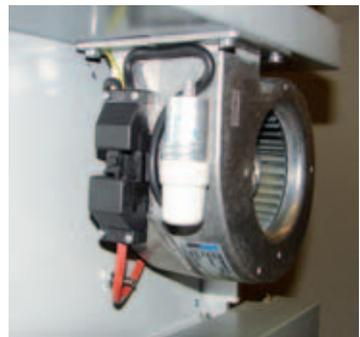
**Hinweis:** Eine staubfreie und saubere Umgebung ist Grundbedingung für den zuverlässigen Betrieb des Gebläses. Der Ventilator ist gelegentlich zu prüfen und zu pflegen. Falls der Geräuschpegel intensiver wird, sollte man die Flügel des Lüfterrades reinigen. Schmutz auf den Flügeln verursacht einen lauten Betrieb und führt zur Veränderung der Parameter, wodurch eine saubere Verbrennung nicht mehr gewährleistet ist.
