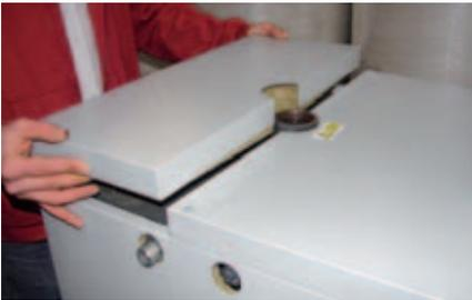
Abnehmen der Wärmetauscherverkleidung (werkzeuglos).
