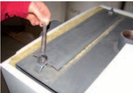
Lösen der Wärmetauscherabdeckung (13er Gabelschlüssel).
