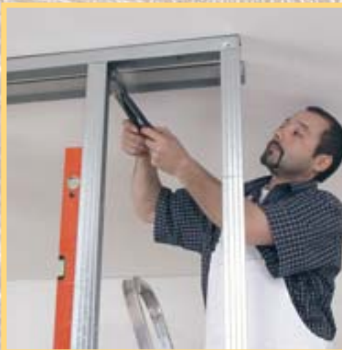
4. Îmbinările verticale sunt executate cu profile speciale. Prințeți apoi de fiecare ramă (în exterior și interior), cu un clește, câte 2 șine metalice.
