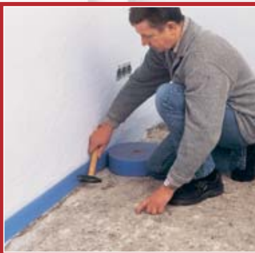
1. Pentru o bună izolare fonică între pardoseală și pereți aplicați mai întâi, de jur-împrejur, o bandă izolantă (noi am folosit un produs pe bază de spumă).
