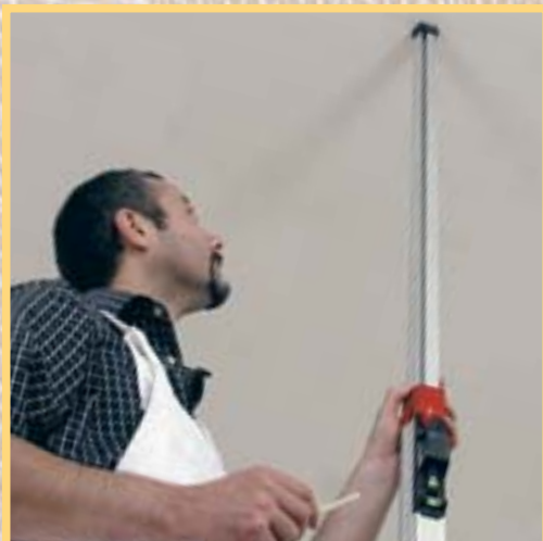
1. Cu ajutorul unei rigle telescopice cu nivelă cu bulă de aer pot fi determinate exact punctele în care veți fixa rama-suport.
