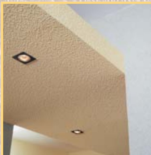
19. În total, am montat opt spoturi pătrate: patru pentru spațiul de luat masa și alte patru în interiorul bucătăriei. Aveți grijă să le amplasați cât mai estetic!
