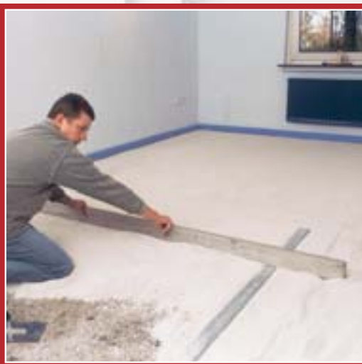
5. După turnarea materialului de egalizare, îl nivelați și apoi îndepărtați șabloanele. Nu uitați că întotdeauna se lucrează înspre direcția ușii.
