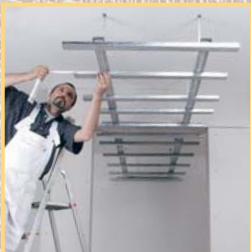
12. Fixați de peretele din spate al bucătăriei profilele longitudinale, pe o șină. Profilele transversale deja montate se poziționează într-o consolă.
