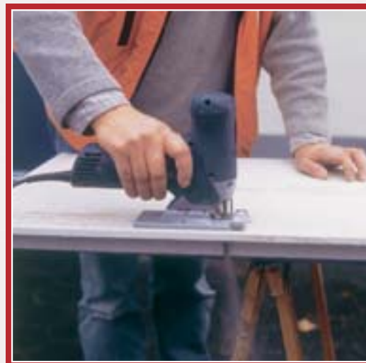
6. Pentru piesele ce vor fi așezate în colțuri, tăiați ambele falțuri proeminente. La restul elementelor de pe primul rând veți îndepărtata doar falțul dinspre perete.
