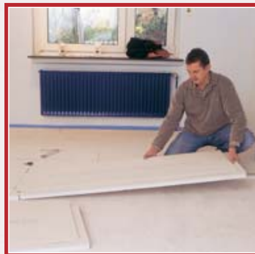
10. ...paralel cu rândul anterior, apoi dați-i drumul încet. Elementele se vor lipi și de-a lungul rosturilor de îmbinare, pentru că adezivul expandează puțin.
