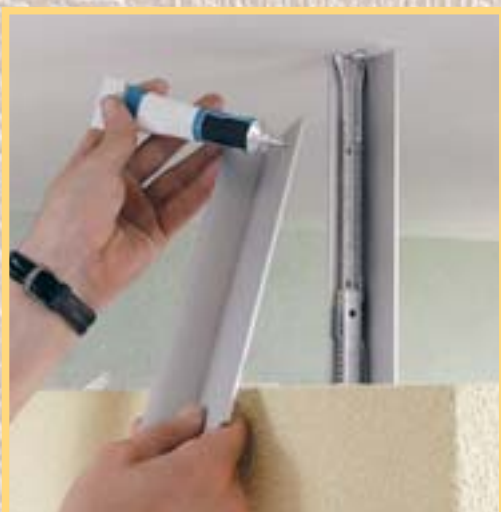
20. Și o ultimă intervenție din rațiuni estetice. Măcați elementele de susținere prin lipirea a două corniere de aluminiu, cu ajutorul unui adeziv pentru metal.
