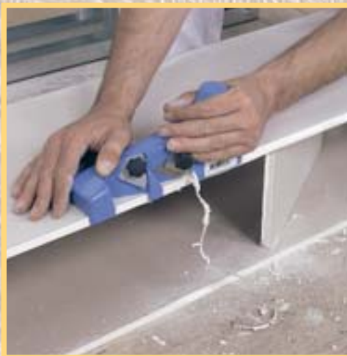
8. Pentru a realiza un rost corect între 2 plăci, muchia uneia dintre ele trebuie fasonată cu o rindea, astfel încât la chituirea rostului adezivul să pătrundă în acesta.
