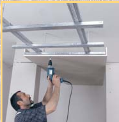
15. Pentru îmbrăcare se folosesc piese fasonate „U” (100 x 1000 x 100 mm). Dacă doriți să evitați depunerea prafului, montați mai întâi plăcile de sus.
