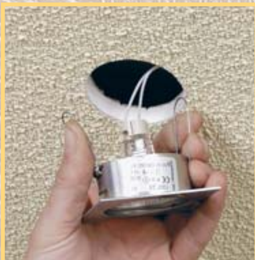
18. Pentru instalarea unor spoturi de lumină, trebuie să efectuați mai întâi decupajele necesare. Fixați apoi spoturile cu niște coliere de susținere.
