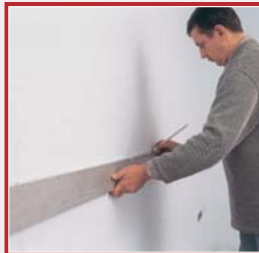
2. La exact un metru peste înălțimea dorită a șapei veți trasa un brâu pe perete. Aceasta este concepută ca reper, distanța până la dușumea trebuie să fie constantă.
