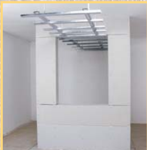
14. Iată scheletul pe care va fi montat tavanul suspendat. Suprafața sa depinde și de dimensiunea mesei deasupra căreia va fi poziționată.
