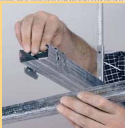
13. Cu ajutorul acestor elemente de îmbinare în cruce profilele transversale pot fi montate foarte ușor. Distanța maximă între profilele portante este de 500 mm.
