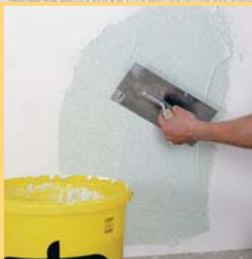
17. Acoperirea peretelui separator poate fi realizată cu o tencuială din piatră naturală, fără conținut de solvenți, aplicată cu o drîșcă din metal. Gletuiți apoi ușor.
