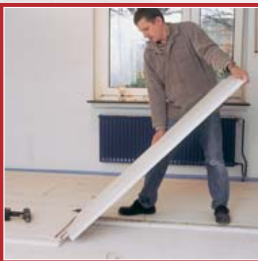
9. În maximum zece minute trebuie să montați următorul element. Deoarece acesta are un falț în trepte, totul va merge foarte ușor. Poziționați-l...
