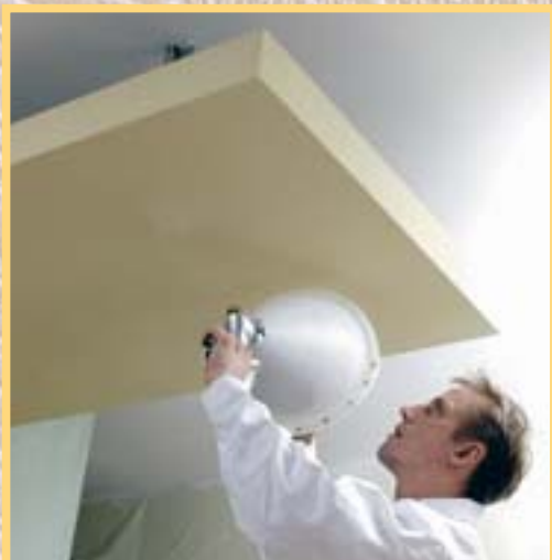
16. După ce șpăcluiți și șlefuiți rosturile de îmbinare, pulverizați de trei ori asupra tavanului dumneavoastră o tencuială fină.
