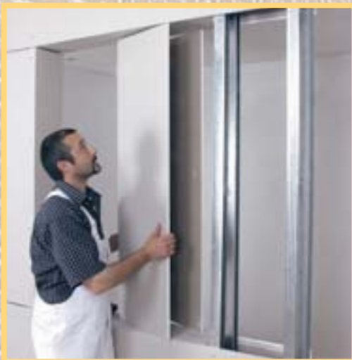
7. Iată cum se poziționează o piesă fasonată pe rama-suport. Partea îngustă rămasă liberă este completată din nou cu o fâșie de placă.
