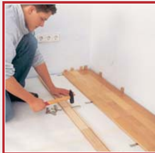
16. Introduceți bridele elastice de fixare din oțel inox în canelurile de prindere de pe partea inferioară a scândurilor lovindu-le ușor cu ciocanul.
