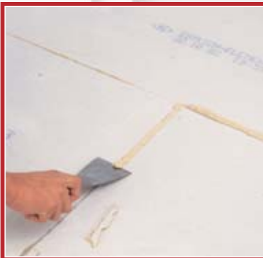
13. Dacă ați procedat corect, atunci va ieși puțin adeziv între rosturile de îmbinare. După uscarea completă, acesta va fi îndepărtat cu ajutorul unui șpaclu.
