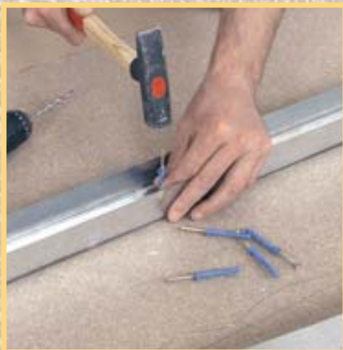
3. Așezați profilele metalice unde ați făcut semnele și apoi fixați-le cu dibluri (nu lăsați o distanță mai mare de 1 m între acestea).
