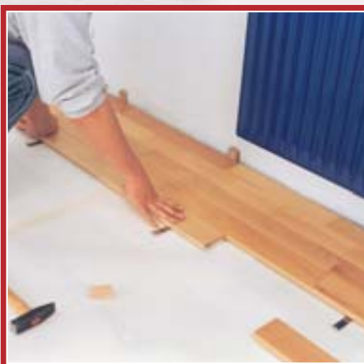
17. Întoarceți scândurile pe partea cealaltă și așezați-le cu brida pe canelura celor montate anterior. Scândurile din același rând vor fi prinse la capete, brida pe canelură.
