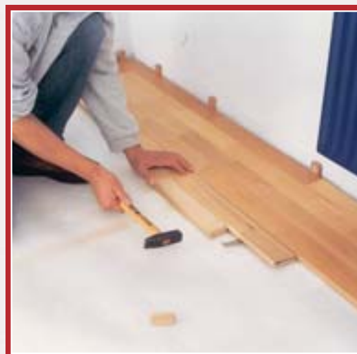
18. Pentru a introduce brida elastică din oțel inox a rândului anterior în canelura de pe partea inferioară a scândurii, utilizați ciocanul și pene ajutătoare din lemn.
