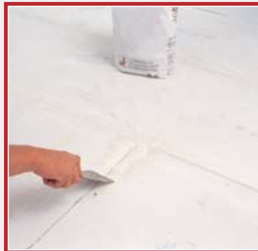
14. În final, rosturile de îmbinare ale elementelor șapei sunt nivelate cu ajutorul unui șpaclu special pentru rosturi. La fel procedați și la capetele șuruburilor.
