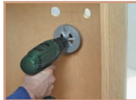
21. Pe dulapul de sub chiuvetă trebuie montate racordurile de apă, iar pe peretele din spate au fost prevăzute orificii de trecere.
