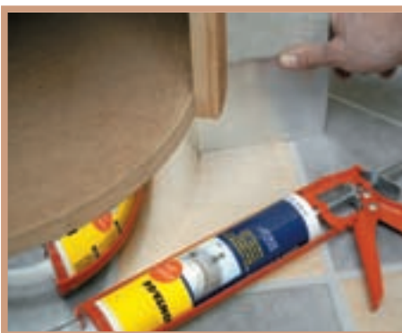
23. După ce ați trecut prin toate aceste etape, puteți lipi sub corpul dulapului o folie de 12 cm din aluminiu, pentru obturarea postamentului.
