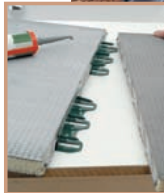
1. Începem prin placarea căzii cu panouri compozite din spumă rigidă, îmbinate și lipite între ele.
