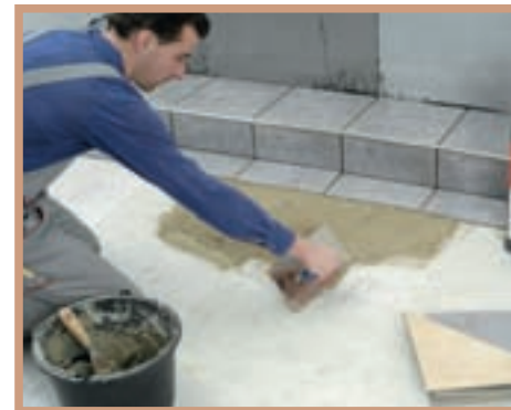
8. ...nu necesită nici o armare ulterioară, iar gresia poate fi montată direct peste adezivul flexibil care a fost aplicat manual.
