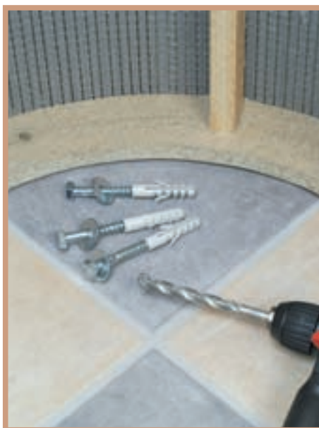
13. Pentru ca turnurile să fie stabile, trebuie ancorate în pardoseală. Astfel, rama de bază va fi prinsă cu șuruburi și șaibe de fixare.
