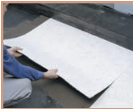
7. Saltelele minerale din poliuretan aglomerat vor fi așezate cap la cap pe patul umed de adeziv. Avantajul saltelelor este că...
