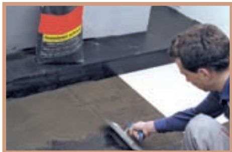
6. ...asigurată o izolație fonică eficientă pe suprafața principală. Pentru aceasta, au fost lipite plăci fonoizolante de 4 mm grosime.
