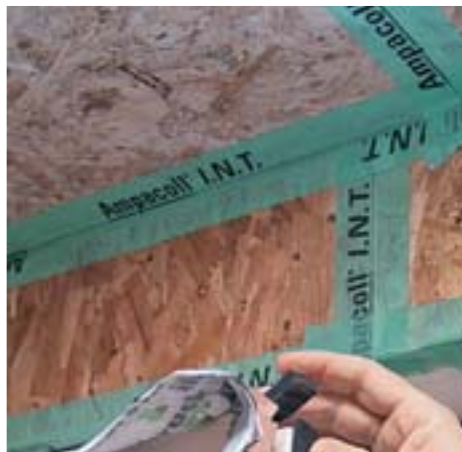
5. La toate colțurile, veți aplica folia flexibilă pentru interior lăsând în afară (sub formă de buclă) o porțiune de aproximativ 3 cm.
