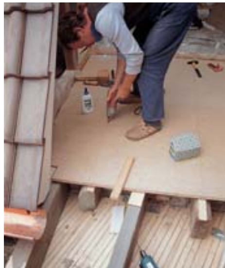
3. Apoi, stratul-suport neted a fost fixat în pantă prin înșurubare. Pe panouri a fost aplicată o substanță rezistentă la umezeală.
