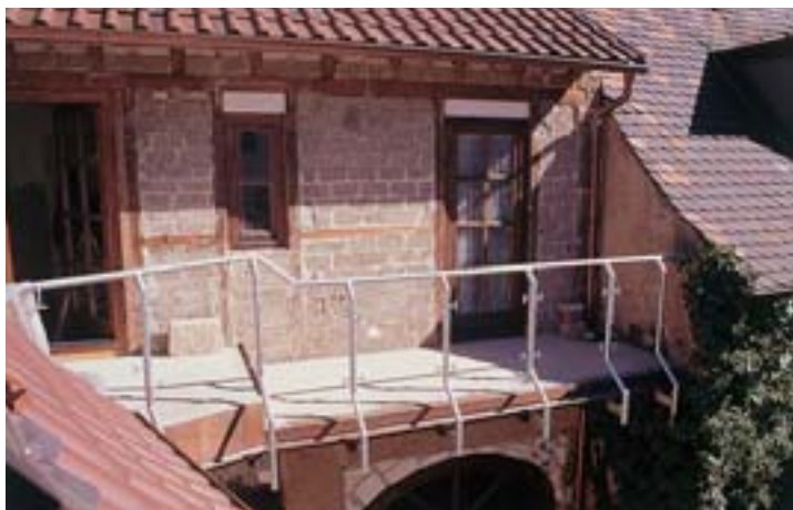
6. Pardoseala a fost acoperită complet cu panouri rezistente. Datorită panourilor montate dedesubt, a fost obținută o pantă lină. Pardoseala a fost apoi etanșată, iar la margine a fost închisă cu o bordură din cupru.
