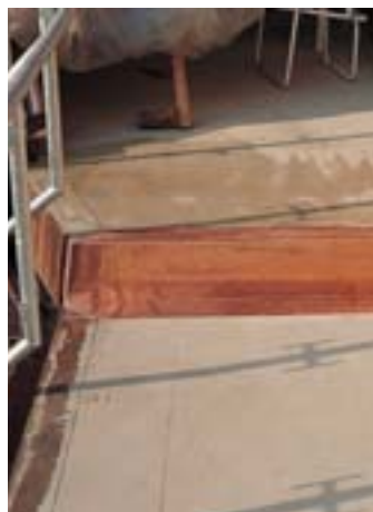
7. Și treapta a fost închisă cu un cornier din tablă de cupru, lipit cu cositor de celelalte închideri.
