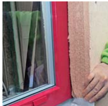
6. Zona dinspre exterior a golului din perete o veți izola cu ajutorul unei benzi elastice din cauciuc butilic, impermeabilă la difuzia aburilor.
