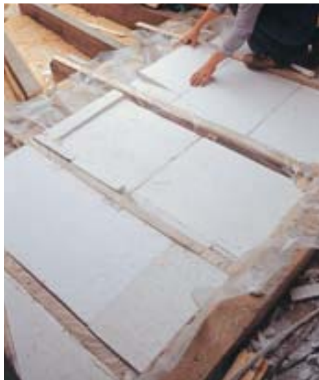
2. Sub zona dezafectată a acoperișului e situată o încăpere locuită. Pardoseala a fost așezată pe o folie între grinzi și etanșată.
