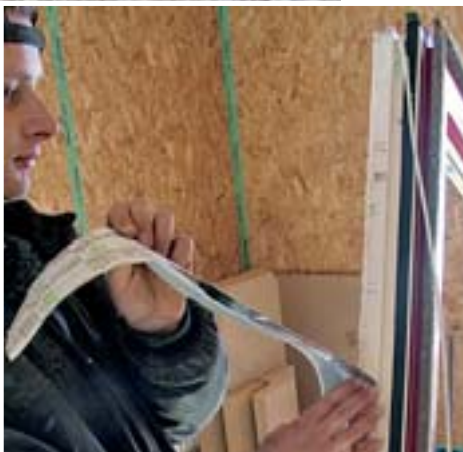
4. ...cașerată cu folie din aluminiu rezistentă la rupere și rigidizată cu țesătură. După ce ați aplicat-o, va trebui să o presați cu grijă.
