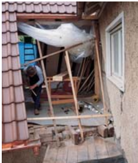
1. Balconul renovat trebuia prelungit și inclus în șarpanta construcției anexă, pentru a crea o mică terasă. Așadar, a fost desfăcut acoperișul.
