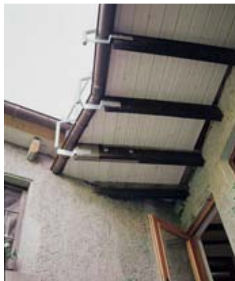
5. Privind de jos vedem fața mai frumoasă a scândurilor profilate. A fost montat deja noul jgheab, dar și balustrada încă nefinisată.
