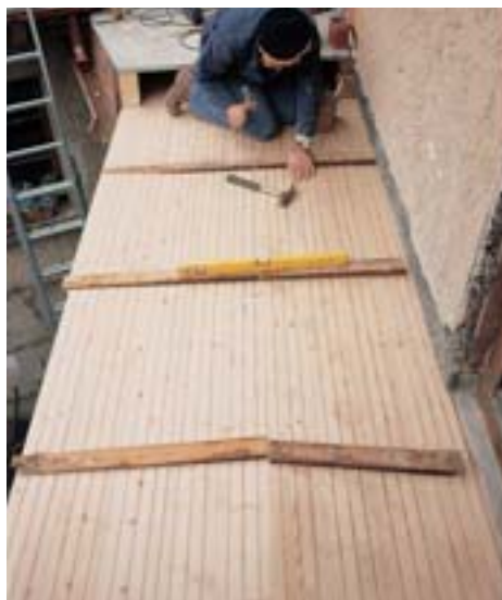
4. În spate se vede zona mai înălțată a terasei, iar în față balconul propriu-zis, acoperit cu scânduri profilate, panta fiind realizată cu pane.
