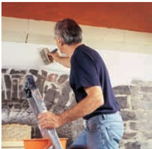
16. La peretele de vizavi, suprafața tencuită, situată deasupra arcadei din piatră, a fost estompată și adaptată în așa fel încât să corespundă formei arcuite.
