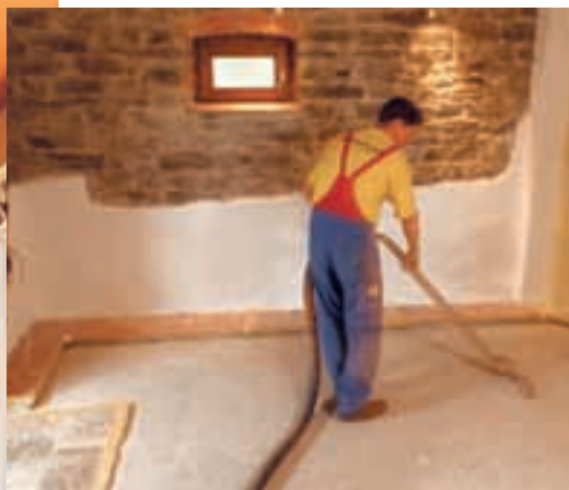
25. Pentru o aderare optimă a pardoselii turnate la betonul brut au fost necesare două operațiuni: desprăfuirea suprafeței și...
