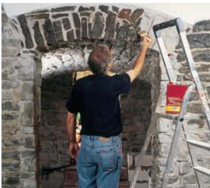
18. Pentru a evidenția mai bine pereții din piatră și arcada, atât pietrele, cât și rosturile dintre ele au fost tratate cu un lac special, ce conferă strălucire calcarului cochilifer, asigurând și protecție împotriva prafului sau eroziunii.
