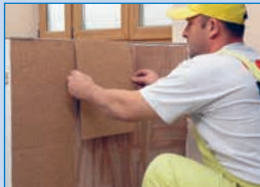
8. Pluta va fi aplicată continuu, pe toată aria laterală. Datorită texturii materialului, rosturile sunt "invizibile".
