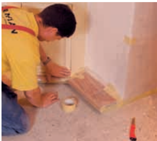
24. După montarea ușii, au fost continuate lucrările la pardoseală. Ca măsură prealabilă, toate zonele limitrofe acestora au fost acoperite atent cu bandă adezivă.
