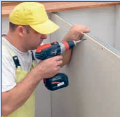
3. La montarea panourilor, distanța dintre punctele de fixare trebuie să fie de cel mult 30 cm. E necesar ca șuruburile să pătrundă în structură circa 20 cm.
