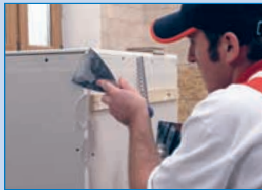
2. Rosturile și denivelările de până la 10 mm vor fi astupate cu un produs pe bază de ipsos aditivat.
