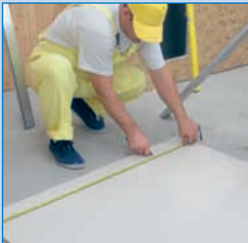
1. Urmează debitarea plăcilor din gips-carton cu un cutter. Vor fi tăiate cu 2-3 mm mai mici decât indică dimensiunile reale, pentru a crea rosturi de dilatare.
