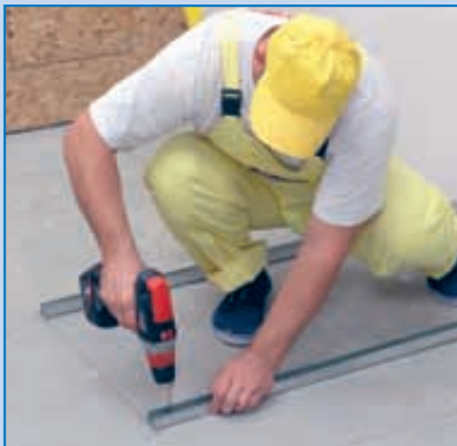
3. Fixarea profilelor în pardoseală trebuie realizată pe tot perimetrul măștii, folosind o șurubelniță cu acumulator și șuruburi cu diblu din plastic sau metal.
