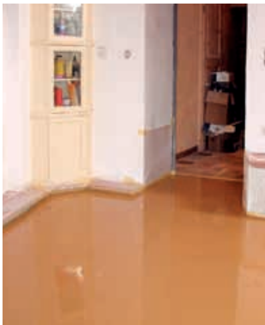
29. Așa arăta șapa de magnezie proaspăt turnată, pe care nu se putea călca încă. Ea a fost aplicată într-un strat de circa 20 mm grosime și nivelată brut.
