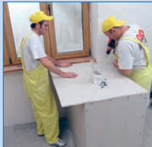
4. Acesta este momentul în care va fi montat blatul măștii, pe care va fi poziționată chiuveta. Capetele șuruburilor trebuie să fie aliniate la suprafața plăcii.
