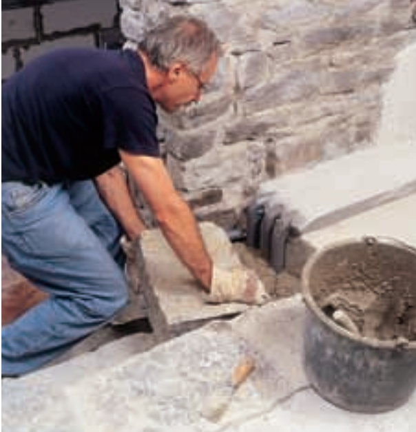
3. Treptele din piatră au servit și la acoperirea țevilor instalației termice care ieșeau din soclul de beton, continuând în jos. Pietrele au fost selectate în așa fel încât...
