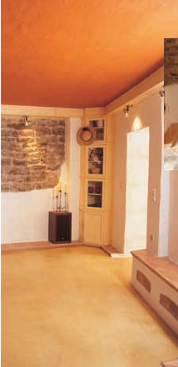
25. Pentru o aderare optimă a pardoselii turnate la betonul brut au fost necesare două operațiuni: desprăfuirea suprafeței și...
