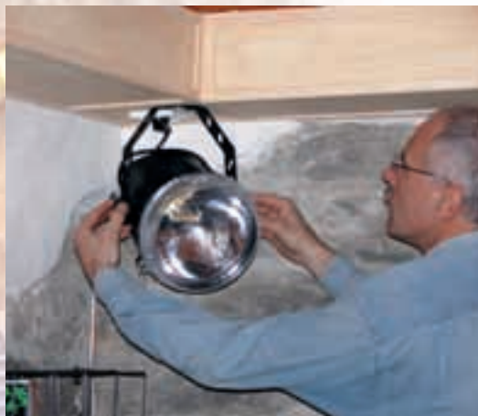
32. A venit momentul să ne ocupăm și de instalația de lumini necesară petrecerilor. Într-un colț al bordurii plafonului a fost montat un stroboscop conectat la o priză.
