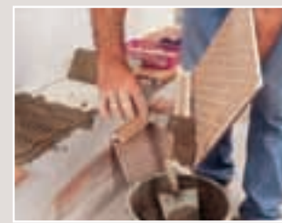
4. ...să rămână suficient spațiu între ele, pentru a putea fi rostuite. După ce mortarul a aderat puțin, rosturile au fost netezite cu o pensulă și multă apă.
