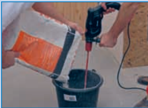
1. Prepararea celor două gleturi pentru interior va fi realizată folosind un malaxor acționat mecanic.
