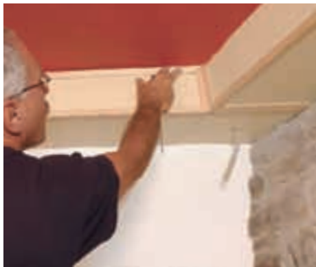
14. La îmbinările pe colț, toate capetele riglelor au fost tăiate în unghi de 45 grade, fapt care a conferit lucrării un aspect profesional.
