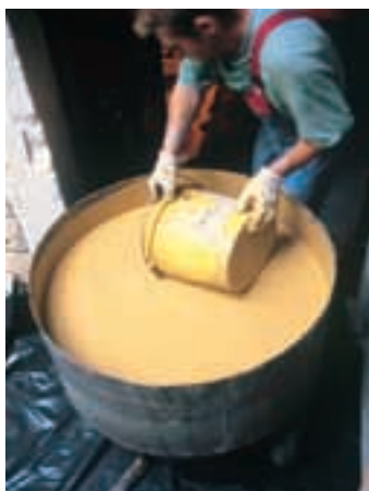
27. Șapa colorată a fost pregătită la fața locului, iar apoi luate cantități mici cu o găleată...
