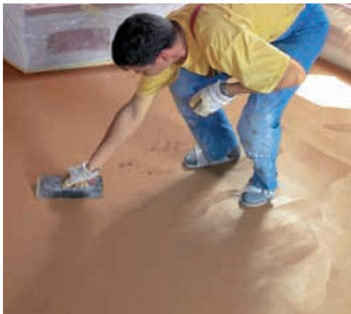
31. ...nu trebuia să fie complet uscată. Alegerea momentului optim depindea de experiența profesionistului. Pentru netezirea pardoselii a fost utilizată o drișcă din plastic, pentru că cele din oțel puteau cauza zgărieturi negre.
