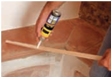
13. Îmbinările dintre plăcile bordurii și cele de la colțuri au fost acoperite cu rigle plate sau la unghi de 90 grade și lipite cu adeziv.
