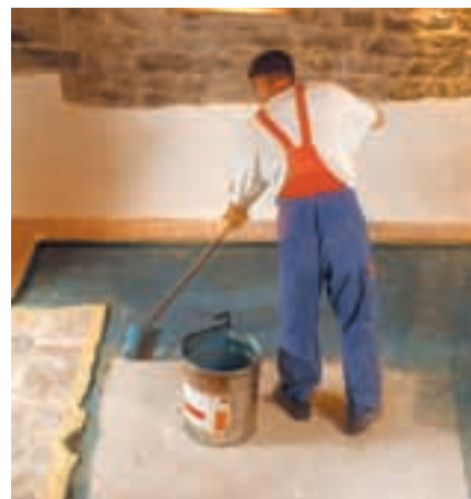
26. ...acoperirea ei cu un strat de grund aplicat cu rola. Această operațiune trebuia efectuată cu o zi înaintea turnării pardoselii.
