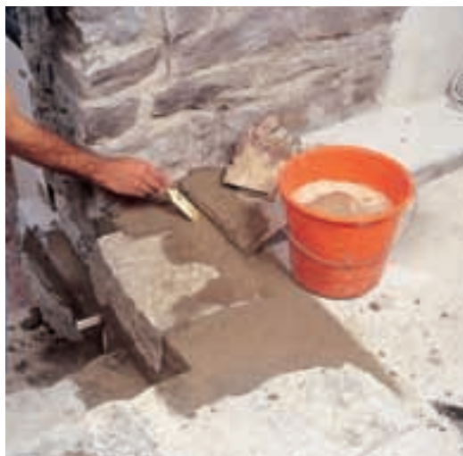
4. ...să rămână suficient spațiu între ele, pentru a putea fi rostuite. După ce mortarul a aderat puțin, rosturile au fost netezite cu o pensulă și multă apă.
