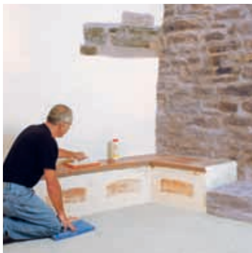
8. După rostuire, a fost îndepărtat excesul de material cu o gletieră cu burete. Puteți remarca faptul că toate cărămizile decorative sunt perfect corelate.
