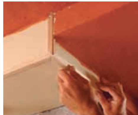
15. Iată cum arată în detaliu un colț exterior în care trei rigle se întâlnesc pe aceeași linie. După montare, structura a fost șlefuită și vopsită.
