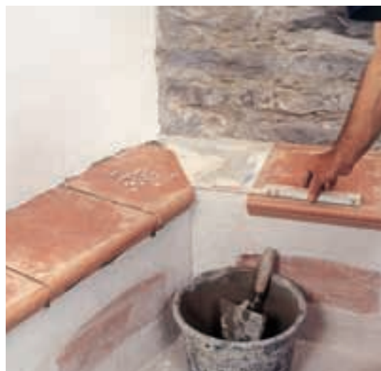
7. Acestea au fost aplicate astfel încât la îmbinarea pe colț, cele două dale ajustate să fie simetrice. De aceea, ele au fost așezate mai întâi de probă, fără adeziv.
