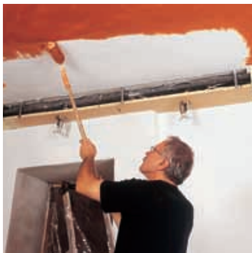
12. Înainte de montarea definitivă a bordurii, plafonul a fost zugrăvit într-o nuanță de roșu-cotto, iar plăcile din PFL dur ale bordurii au fost tratate cu o vopsea de efect.
