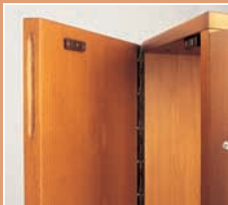
4. Fixată cu o balama tip bandă, ușa dulapului poate fi deschisă mânuind concavitatea muchiei și menținută în poziția închisă cu un opritor magnetic.
