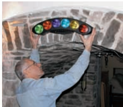
33. Pe arcada încăperii boltite a fost amplasată o orgă de lumini cu șase canale, cu o formă adecvată liniei arcuite. Aceasta poate fi acționată de la pupitrul DJ-ului.
