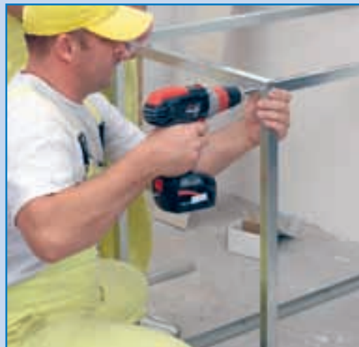
4. Cadrul metalic va fi montat utilizând șuruburi autofiletante. Treptat, structura de rezistență a măștii pentru chiuvetă va lua forma unui paralelipiped.
