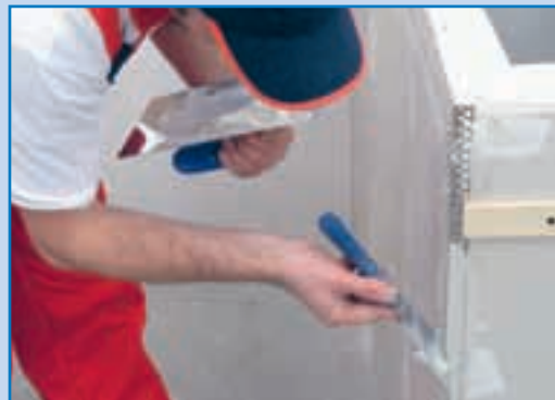
4. Va fi încorporat profilul în masa gletului până ce se întărește, apoi nivelat cu atenție.
