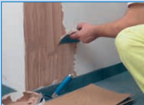
7. Suprafețele exterioare ale măștii vor fi acoperite pe porțiuni cu un adeziv special și folii subțiri de plută.
