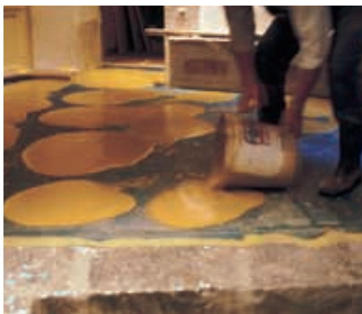
28. ...și duse în cameră. Lucrarea a fost începută de la peretele din spate și continuată spre accesul în subsol, conținutul găleților fiind distribuit uniform.
