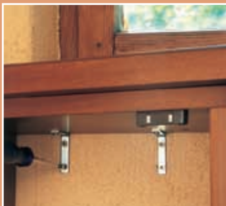
5. Dulăpioarele – fără tăblia din spate – au fost fixate în perete cu corniere, pentru a preveni răsturnarea întregului ansamblu.
