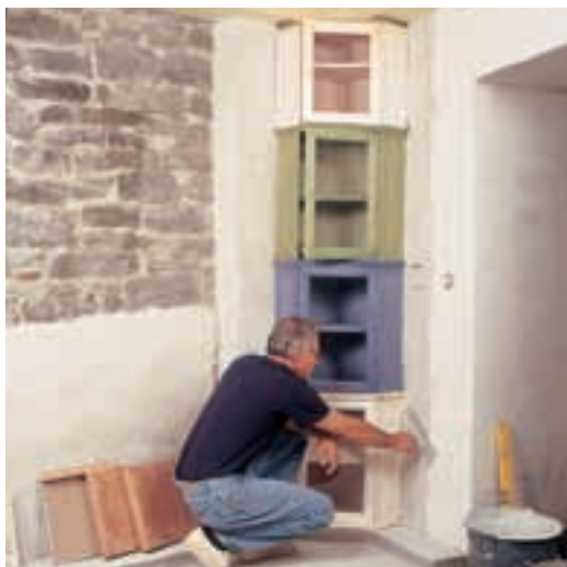
17. Dulapul de colț e alcătuit din patru corpuri suprapuse, dimensionate astfel încât ansamblul să ocupe toată înălțimea încăperii. Tencuiala adiacentă a fost finisată.
