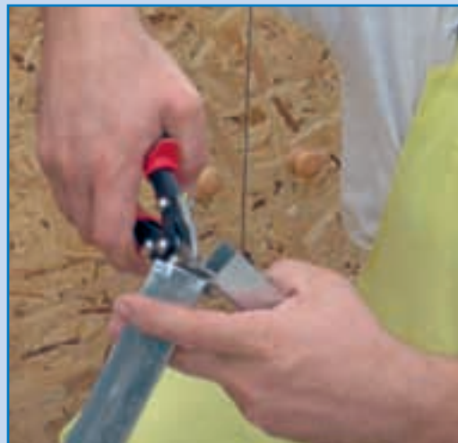
2. Tăierea va fi executată cu ajutorul unei foarfeci pentru tablă. Dacă nu aveți una profesională (electrică), varianta manuală vă este la fel de utilă.
