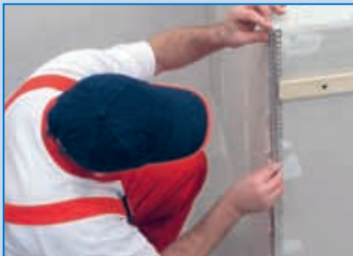
3. Un profil de colț din aluminiu va împiedica apariția crăpăturilor cauzate de modificări dimensionale.
