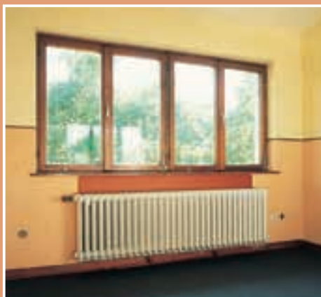
1. Inițial, pe suprafața peretelui de sub fereastră era montat un calorifer cu elemente în serie. Deși funcționa fără cusur, nu era prea aspectuos.
