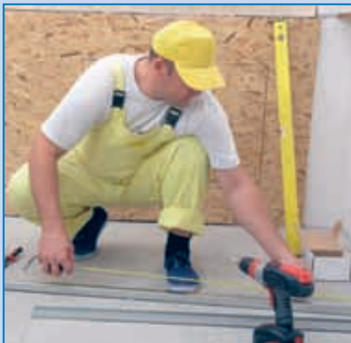
1. Prima etapă presupune debitarea profilelor. Pentru aceasta, măsurătorile trebuie efectuate atent, întrucât o mică eroare poate afecta forma finală a măștii.
