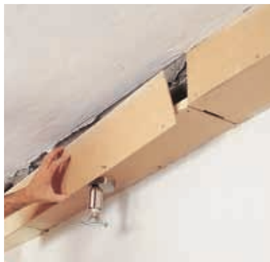
11. ....„compartimente“ cu dimensiuni egale. Plăcile frontale au fost prinse tot cu șuruburi, în spatele lor aflându-se țevile de încălzire, cablul electric și cel pentru boxe.
