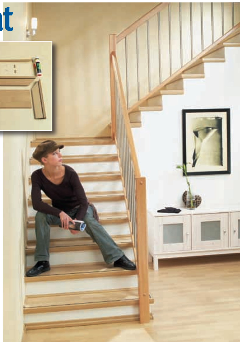
lăță profilul marginal frontal, cele laterale, plus șipcile. Lamela obișnuită din laminat poate acoperi atât treptele, cât și contratreptele
