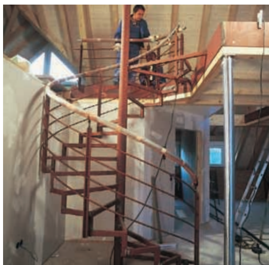
11. Acum, meseriașii assemblează balustrada terminală a supantei. Montanții din profile de oțel (T) sunt fixați în exteriorul supantei, de reperul frontal din pardoseala ei.
