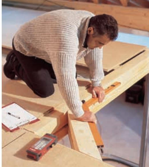
4. Proiectantul poziționează scara, măsurând unghiurile și distanțele cu un aparat cu laser, pentru a realiza o îmbinare precisă a acesteia cu pardoseala supantei.
