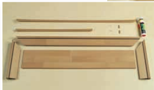
lăță profilul marginal frontal, cele laterale, plus șipcile. Lamela obișnuită din laminat poate acoperi atât treptele, cât și contratreptele
