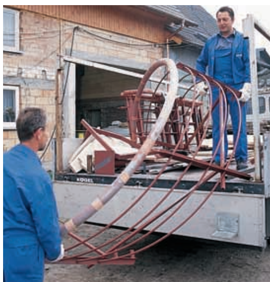
7. După grunduirea structurii de rezistență cu o vopsea anticorozivă și protejarea mâinii curente cu o husă din material spongios, scara este demontată și livrată.
