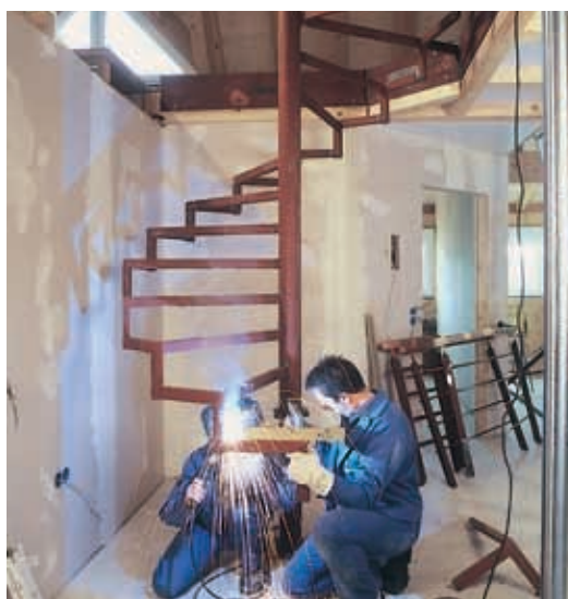
8. Structura de rezistență a podestului este sudată de reperul aplicat frontal pe pardoseala supantei. Apoi e montat stâlpul central și suportii suspendați în consolă.
