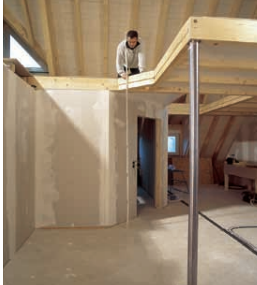
3. Pardoseala brută de la parter și plafonul brut al supantei sunt finalizate. Acum poate fi determinată înălțimea scării cu ajutorul unui metru pliant foarte lung.
