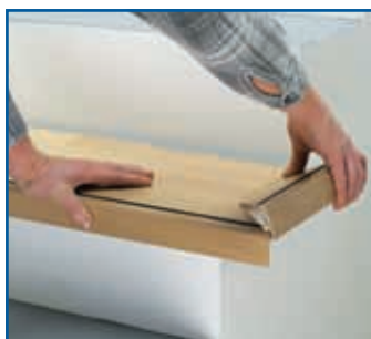
lăță profilul marginal frontal, cele laterale, plus șipcile. Lamela obișnuită din laminat poate acoperi atât treptele, cât și contratreptele
