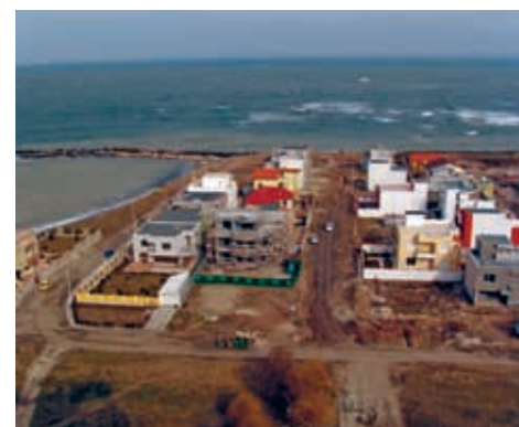
Lucrările recente au schimbat fundamental aspectul și stabilitatea țărmului românesc.
