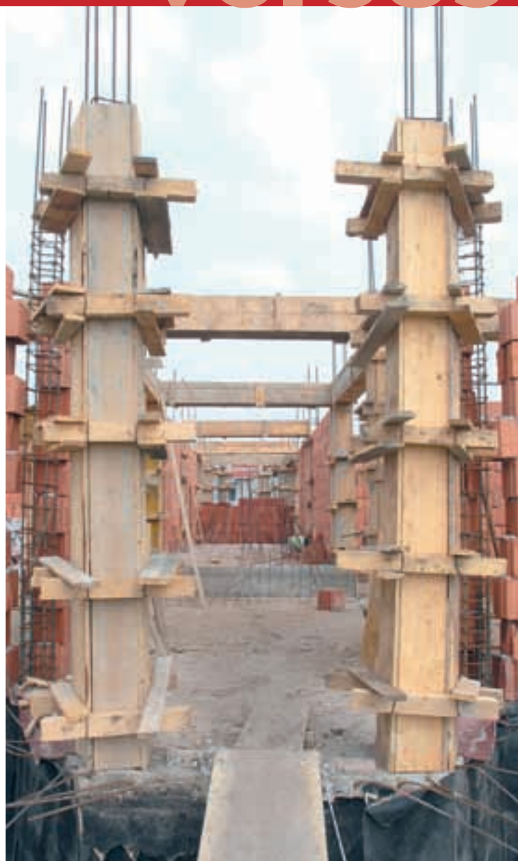
Cofrajele din lemn sunt alternativa inferioară a cofrajelor din plăci compozite sau a celor din metal, deoarece nu au aceeași planitate.
