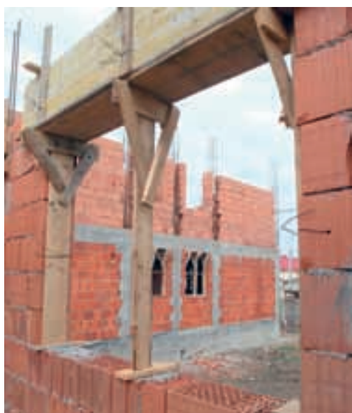
Betonul este turnat și lăsat în aer liber până când se întărește, prin urmare sunt contraindicate temperaturile cu valori negative. Chiar dacă acest lucru nu este un secret, mulți constructori nu țin cont de el.
