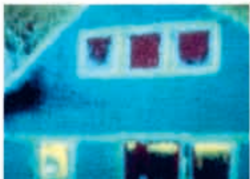
Termograma ferestrelor montate cu spuma poliuretanică Ceresit Megafoam
