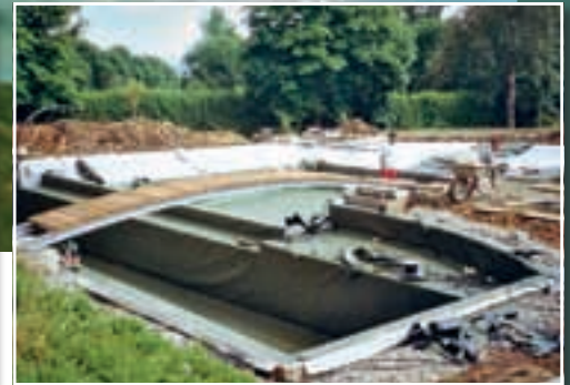
3. Două șine, sudate la fața locului, la distanța de 2 m, servesc la construcția podețului.
