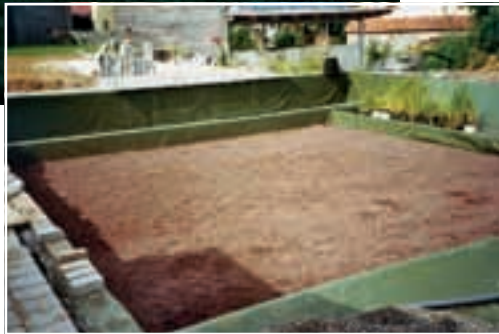
7. În continuare, sunt aplicate granule de filtrare semifine (prin același procedeu), pe circa 15 cm înălțime...
