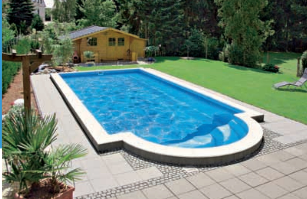
Piscina pe care v-o prezentăm în fotografia de mai sus se distinge prin pereții ușor înălțați peste nivelul solului. Bordura din beton e pusă și mai mult în valoare prin placarea cu materiale ase mă nătoare pietrișului fin sau marmurei combinate cu siliciu și cuarț.
