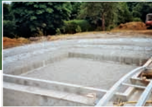
2. Primul strat de piatră de râu grosieră împrăștiat pe fundul porțiunii de regenerare oferă protecție foliei.
