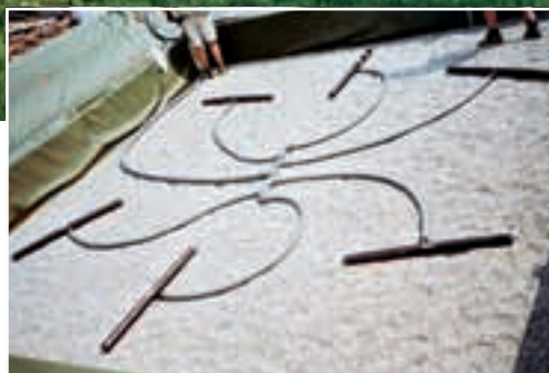
5. Pe acest strat de pietriș brut au fost amplasate țevile cu conducte de insuflare aferente instalației de filtrare.
