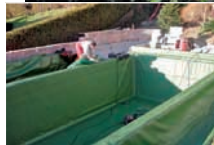
2. Folia a fost fixată foarte exact pe forma bazinului, fiind apoi continuată mult peste marginea acestuia.
