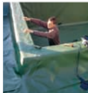
1. Pentru protecție, pe vechea piscină s-au aplicat o pătură drenantă fibroasă și o folie.
