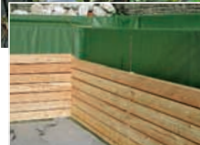
3. Pentru a fi mai aspectuos, bazinele au fost plătite pe interior cu lemn de molid îmbinat pe colț cu dinți trapezoidali.
