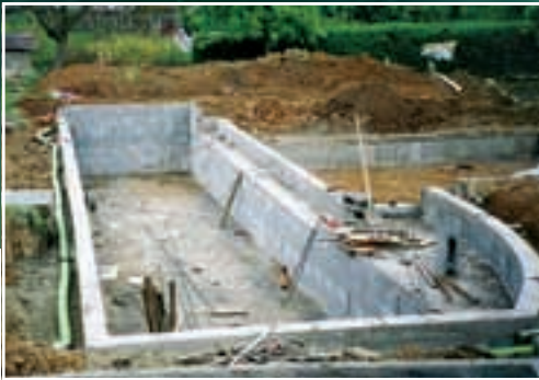
1. Mai întâi a fost executat, din beton, conturul ambelor zone: cea de înot, respectiv de regenerare.
