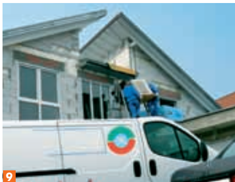
9 Componenta de la exterior e transportată pe un acoperiș aflat la o cotă mai joasă. După amplasare, ea nu mai e vizibilă de la nivelul solului.
