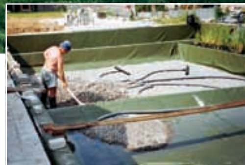
6. Țevile sunt acoperite apoi cu un ultim strat de piatră de râu grosieră, cu dimensiunea de 64 mm.
