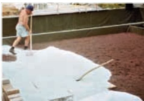
8. ... Împrăștiind apoi, pe întreaga suprafață, balast de morenă foarte mărunț, cu dimensiunea de 8 mm.
