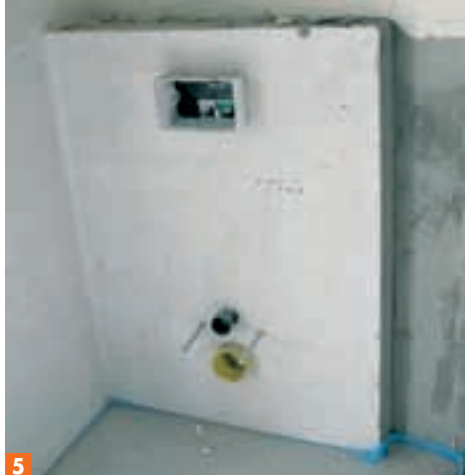
5 Pe suprafața peretelui toaletei au fost deja montate conductele de evacuare a apei de condens aferente celor trei aparate de climatizare din încăperi.
