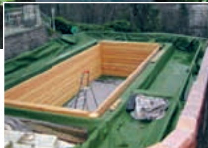
4. Folia a fost aplicată și în zona de epurare destinată filtrării apei, care a fost separată constructiv de piscina propriu-zisă.
