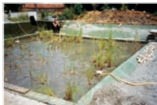
10. Acum nu mai trebuie decât să umpleți complet cu apă ambele zone: de regenerare și pentru înot.
