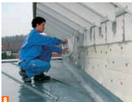
8 Conductele prin care circulă agentul frigorific și cablurile de alimentare cu energie electrică a unității din exterior ajung până sub streșina acoperișului.
