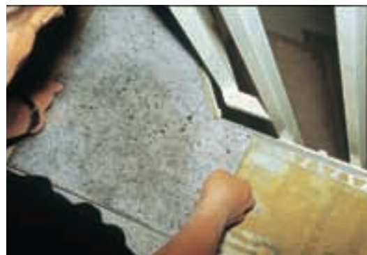
7. Se potrivește! Aplicarea profilelor terminale și restului dalelor e continuată abia după uscarea bucății decupate.
