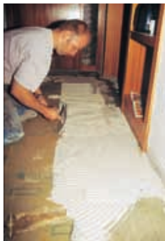
3. Adezivul special pentru roci naturale e amestecat cu telul, fiind aplicat și apoi nivelat cu șpaclu dințat.
