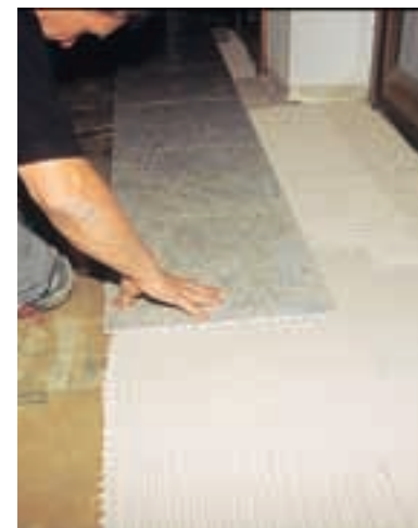
4. Dalele de granit sunt presate în patul de adeziv. Alinierea poate fi verificată cu ajutorul unui dreptar.
