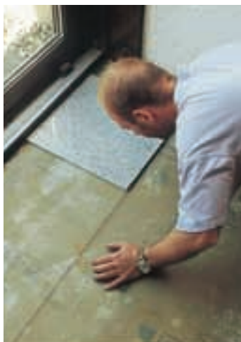
2. Prima dală trebuie așezată în colțul de lângă fereastră. Marcați apoi o linie, cu sfoara de trasat.
