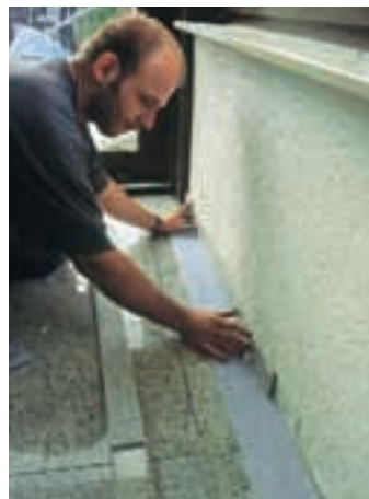
9. Un cordon de spumă servește ca distanțier pentru plintă. Rostul va fi completat ulterior prin pulverizare.
