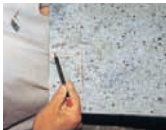
5. Una dintre dale trebuie decupată, suprafața respectivă fiind delimitată prin linii trasate cu un creion cerat.
