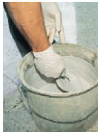
10. Mortarul flexibil de rosturi indicat pentru piatră naturală este amestecat cu atenție și ...
