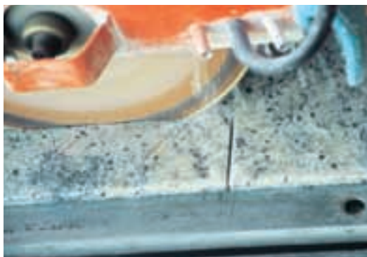
6. Decupajul va fi executat însă în afara casei, cu ajutorul unui flex sau ferăstrău de retezat piatră la umed.
