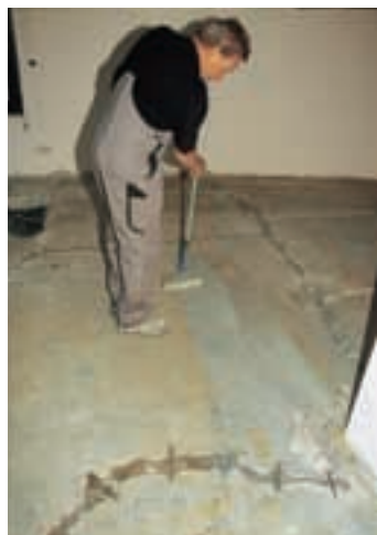
1. Grundul de aderență este aplicat nediluat, folosind în acest scop o rolă fixată pe o tijă telescopică.
