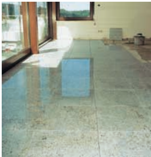
5. Una dintre dale trebuie decupată, suprafața respectivă fiind delimitată prin linii trasate cu un creion cerat.
