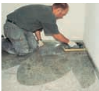
12. Imediat ce mortarul dintre rosturi începe să se usuce, suprafața va fi curățată cu o gletieră cu burete.
