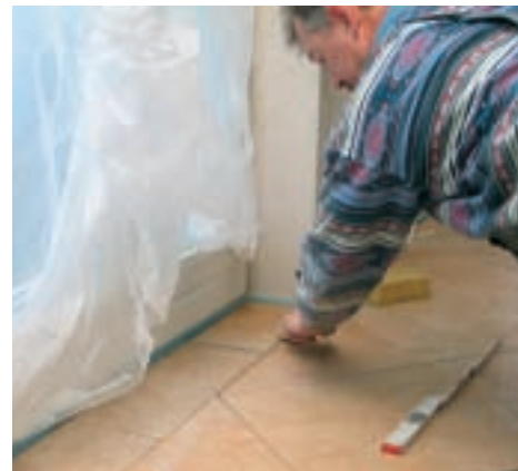
21. În zona limitrofă cu ușa terasei, dalele nu au mai fost dispuse pe diagonală, ci s-a optat pentru debitarea lor în formă rectangulară.
