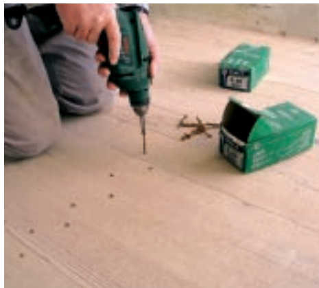
1. Mai întâi, vechile scânduri au fost fixate prin înșurubare pe stratul suport existent. Șuruburile autofiletante trebuie dispuse în zig-zag.
