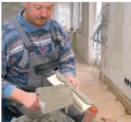
23. Folosind o mistrie, a fost aplicat mortar adeziv pe partea posterioară a plintelor din gresie, acesta având și rolul de a nivela simultan...
