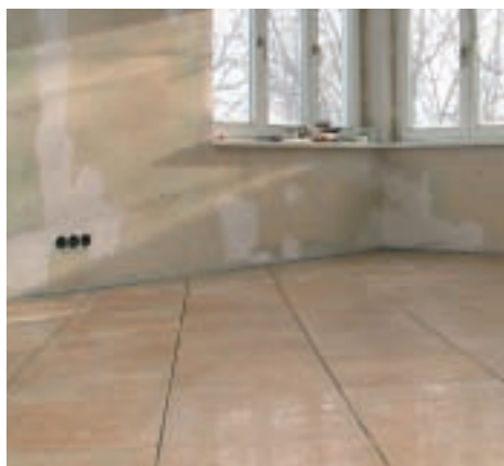
16. ... au fost așezate apoi, pe diagonală, plăcile de gresie din ceramică fină pe toată suprafața, până în celălalt capăt al încăperii.
