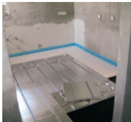
6. ... de pe conturul încăperii, au fost montate benzi termoizolatoare. Cu același material vor fi acoperite și restul suprafețelor perimetrale.
