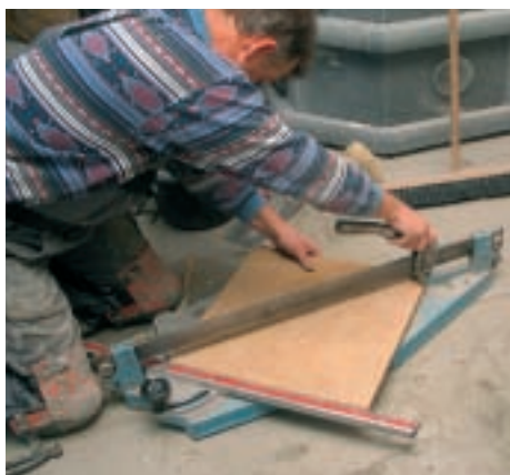
14. Plăcile de gresie au fost dispuse diagonal. Pentru tăierea de-a curmezișul a dalelor mai mari, e necesar un aparat corespunzător ca dimensiuni.
