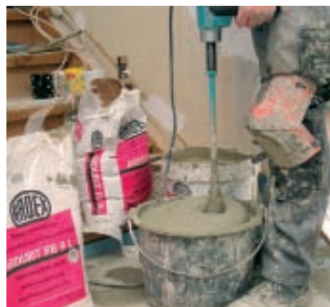
18. Mortarul poate fi consumat optim doar pentru un timp limitat. De aceea, el trebuie amestecat periodic și aplicat rapid.
