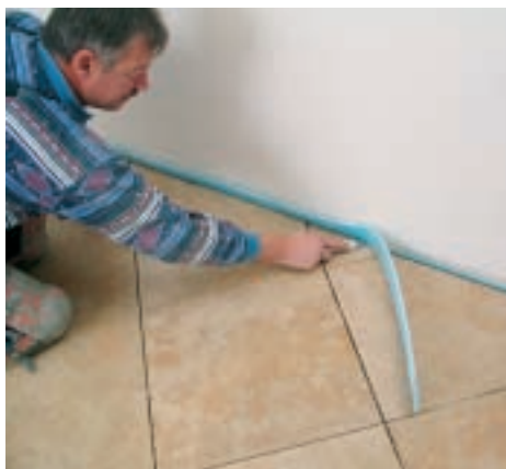
22. Marginea benzilor de material termoizolator dispuse perimetral poate fi îndepărtată abia după executarea întregii structuri a pardoseli.
