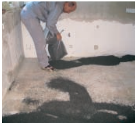
3. Materialul de umplutură (argilă expandată) a fost împrăștiat uniform, pe toată suprafața neregulată a dușumelii.
