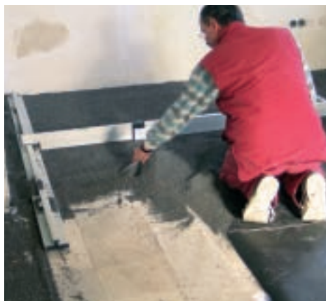
4. Folosind o sculă de nivelat, materialul de umplutură urmează a fi egalizat. Dacă înălțimea lui nu depășește 60 mm, nu trebuie compactat.
