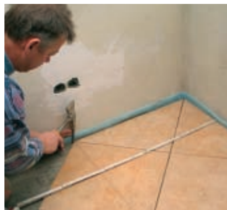
15. În colțul de unde a început montarea, au fost aplicate, de probă, câteva jumătăți de dală împreună cu altele întregi. De-a lungul unei sfori...
