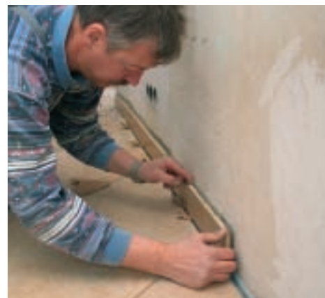
24. ... toate neuniformitățile peretelui. Pentru a realiza un rost corect între pardoseală și perete, plintele au fost prinse la partea inferioară cu pene.
