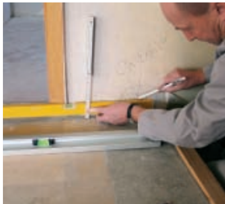
2. Începând de la reperul trasat la 1 m deasupra înălțimii prestabilite a pardoselii, a fost marcată limita superioară a stratului de egalizare.
