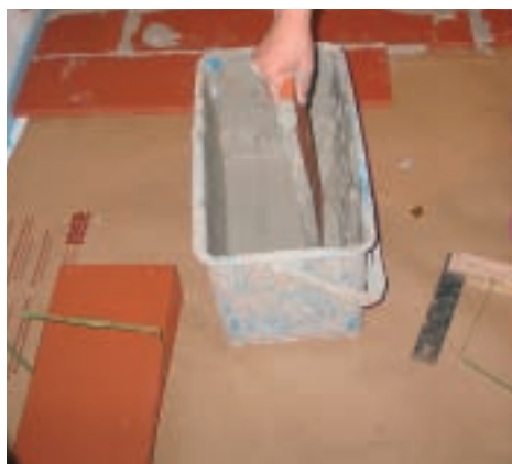
10. Peste acesta, au fost așezate cărămizile de șapă, începând din spatele încăperii, de la colțul din stânga. Cufundându-le oblic în adeziv...
