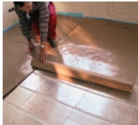
9. Urmează un strat de etanșare și separare aplicat cu suprapuneri de 10 cm. El asigură detașarea suprafeței de încălzire de cea a șapei.
