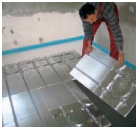
5. Următorul strat, compus din elementele instalației de încălzire, este aplicat conform planului de pozare. Pe toate zonele proeminente...
