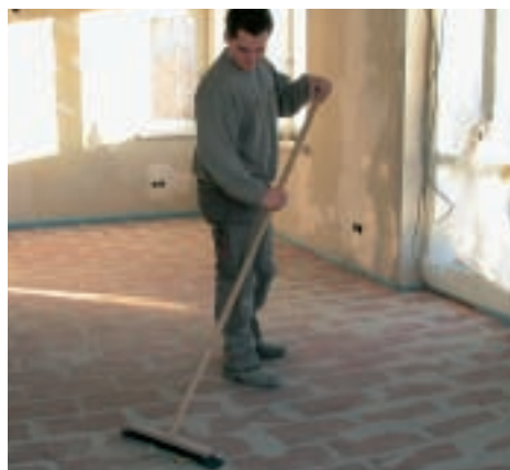
13. După 12 ore, pe șapa din cărămidă se poate circula. Înaintea aplicării gresiei, trebuie îndepărtate toate fragmentele desprinse din șapă.
