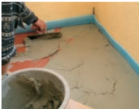
19. Folosind o mistrie, mortarul adeziv a fost aplicat pe șapă și uniformizat cu o gletieră cu zimți. Operațiunea trebuie efectuată dinspre perete...
