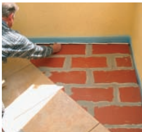
17. După aceea, în această porțiune a camerei trebuie dimensionate separat și debitate corespunzător câteva bucăți de gresie.
