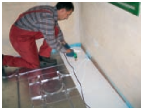
7. În materialul termoizolator alipit peretelui, au fost practicate, cu un aparat electric de tăiat, canaleuri aferente conductelor circuitului de încălzire.
