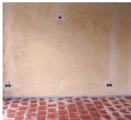
12. Pe parcursul lucrării, excedentul de adeziv a fost îndepărtat cu ajutorul unui șpaclu, imediat ce a început să facă priză.
