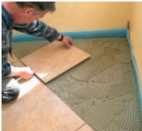
20. ... așezând apoi rapid plăcile de gresie deja pregătite în patul umed de mortar și presându-le complet în acesta.
