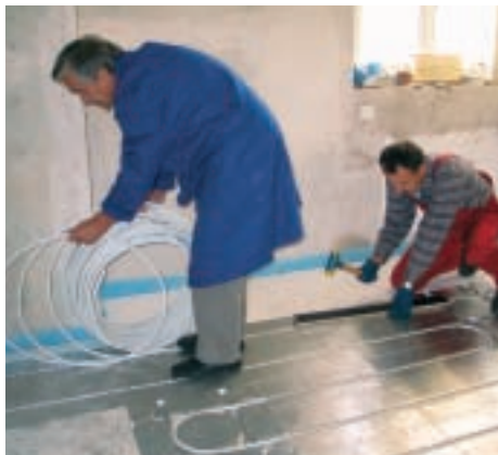
8. Tubulatura a fost desfășurată dinspre distribuitor, colacul fiind sprijinit și cu piciorul. Apoi a fost introdusă în elementele de pardoseală.
