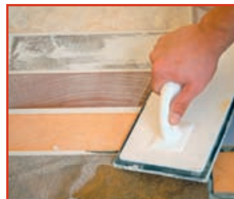
26. După uscarea plăcii ceramice, suprafața trebuie chituită cu gletiera de cauciuc.
