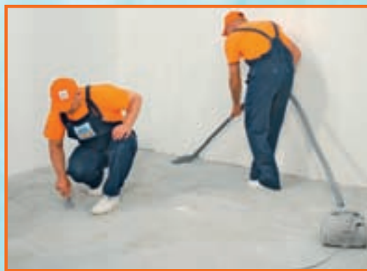
13. Urmează amorsarea podelei. Dar, înainte, pardoseala va trebui curățată de orice material antiaderent.
