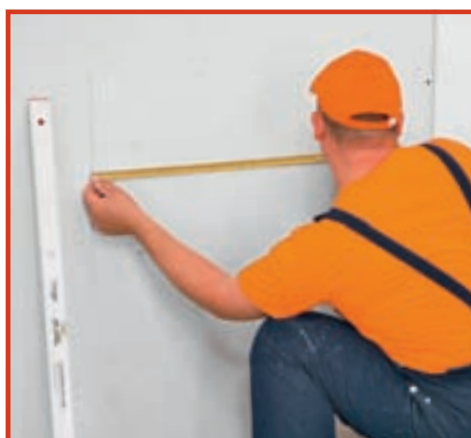
6. Realizarea unei nișe în mască presupune măsurarea exactă a zonei decupate.
