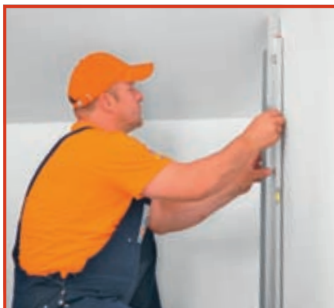
3. Inițial, se fixează în perete profilele ce vor susține amenajarea în plan vertical.
