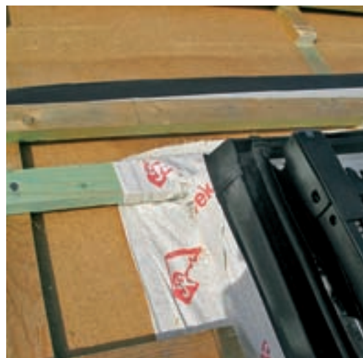
11. Marginile foliei se vor trece pe sub toate șipcile de susținere, înfășurând la colțuri șipcile de montaj. Doar în acest fel e garantată o etanșare durabilă în timp.
