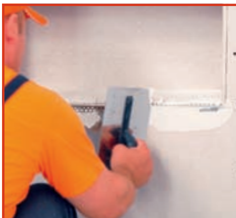
13. După ce profilul metalic a fost imobilizat, pasta a fost uniformizată iar surplusul de glet, îndepărtat.
