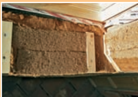
Între marginile scândurelor a fost introdus materialul termoizolant (plăci fibrolemnoase moi), după ce a fost debitat exact la dimensiuni.
