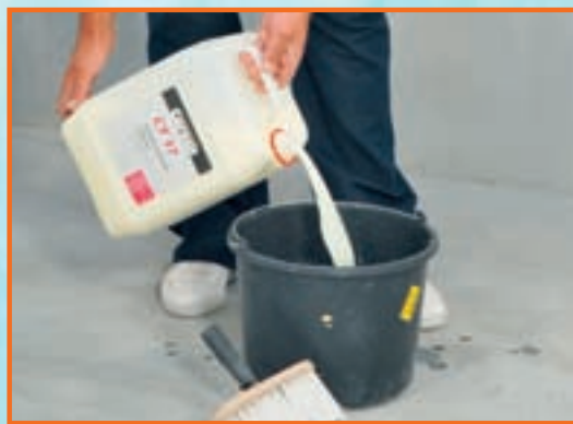
5. Pentru amorsarea pereților, am ales un grund de profunzime, fără solvent, rezistent la factori agresivi.
