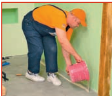
27. Adezivul pentru fixarea parchetului se poate turna direct din recipient, pe pardoseală.
