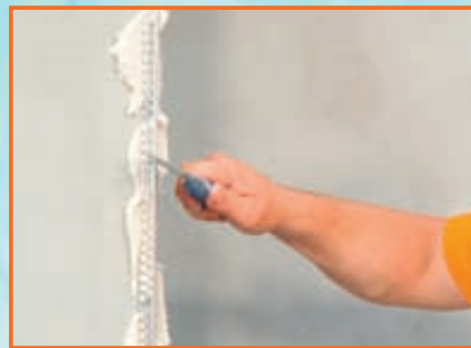
8. Gletul va îngloba complet colțarele ce trebuie debitate după o măsurare exactă.
