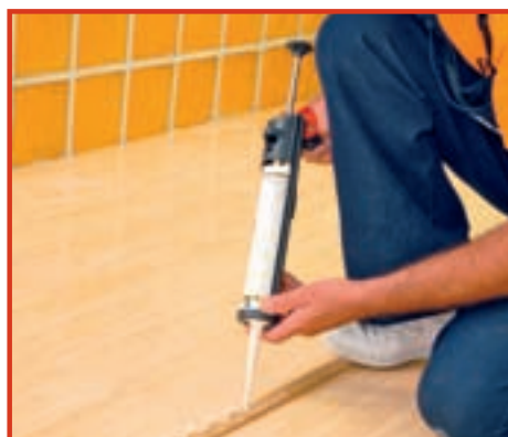
31. Plinta se va lipi cu un adeziv special, aderent atât la lemn cât și la suprafețe sintetice.
