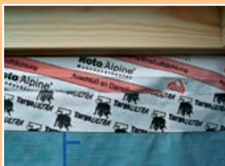
Bariera de vapor trebuie lipită foarte etanș de folia impermeabilă (alb cu roșu).
