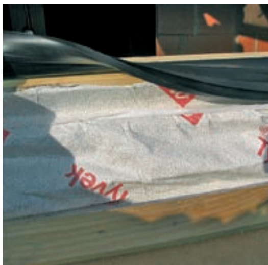
10. Folia autoadezivă trebuie aplicată peste fiecare bloc termoizolant, pentru a proteja tot cadrul ferestrei, urmând să fie fixată pe tocul acestuia cu un cheder din cauciuc.
