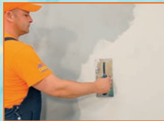
10. După întărirea colțurilor, se poate aplica primul strat de glet. Se folosește o gletieră metalică obișnuită.
