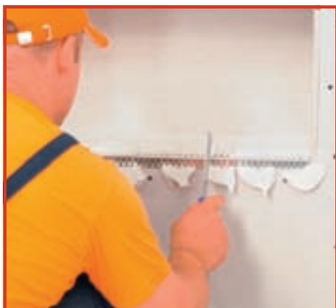
12. Fixarea elementelor metalice se face cu un strat de glet, ce va funcționa ca un adevărat adeziv.
