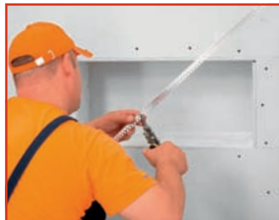
11. Tot experiența dictează și în cazul finisării colțurilor – acestea vor fi consolidate cu colțare din aluminiu.
