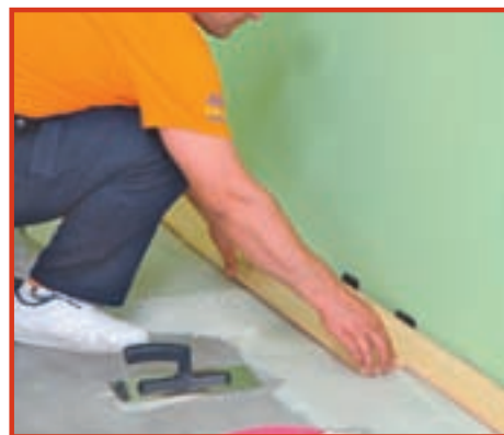
29. Montajul a început dintr-un colț al încăperii. Se lasă un rost de dilatare între perete și parchet.
