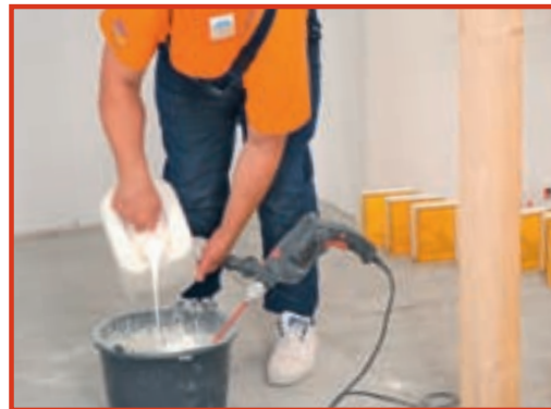
16. Pentru a îmbunătăți proprietățile adezivului, am ales să-l aditivăm cu o emulsie elastică.
