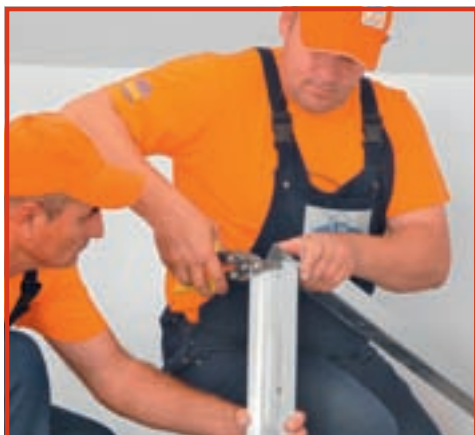
2. După ce au măsurat, meșterii au tăiat profilele metalice cu o foarfecă de tablă specifică.
