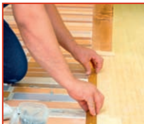
34. Găurile din pragul metalic trebuie să corespundă celor realizate în pardoseală.
