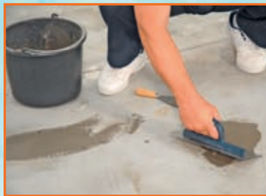
16. Corectarea cu pasta de umplere se va face utilizând o simplă gletieră metalică.
