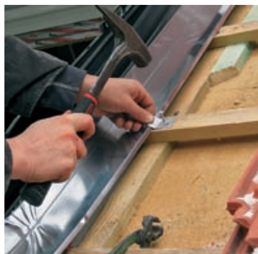
15. Ramele de acoperire sunt fixate în șipcile de susținere a țiglelor cu bride și cuie. Marginea din tablă îndoită în unghi împiedică infiltrarea apei sub nivelul țiglei.
