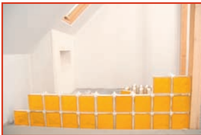
20. Zidul a înce-put să prindă contur. Sensul de construcție este dinspre stâlpul de lemn către marginea încăperii.
