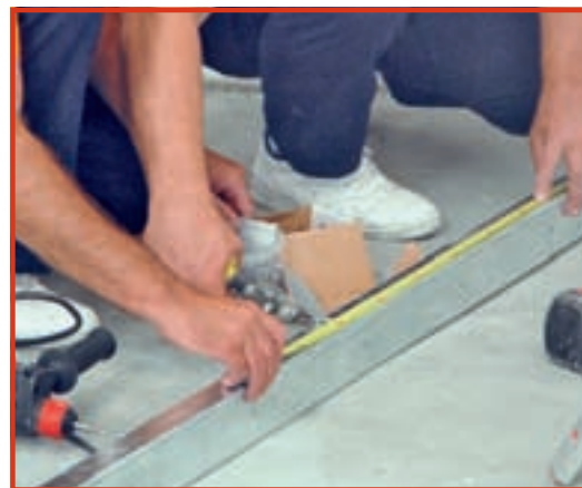
1. Construcția începe cu realizarea măștilor din gips-carton, respectiv cu debitarea structurii metalice.
