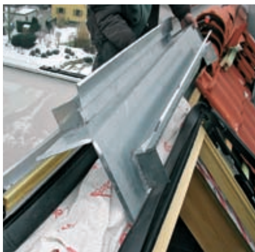
20. Profilul de acoperire aplicat peste coamă se potrivește perfect între cele două ferestre datorită confecționării lui într-un unghi corespunzător.
