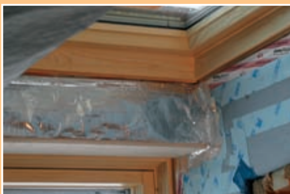
Între marginile scândurelor a fost introdus materialul termoizolant (plăci fibrolemnoase moi), după ce a fost debitat exact la dimensiuni.
