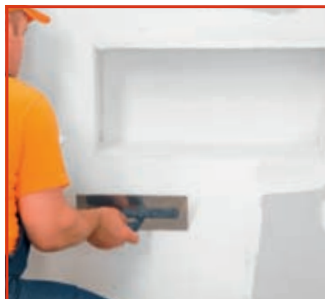
14. Imperfecțiunile rezultate au fost acoperite. Suprafața se finisează cu glaspapir.
