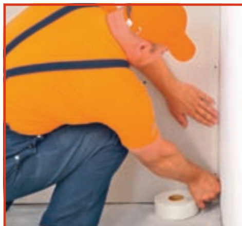
10. Experiența i-a învățat pe meșteri că o astfel de construcție trebuie întărită cu bandă de armare.
