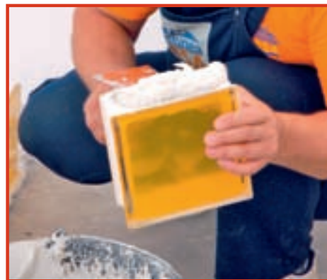
19. Pentru o asamblare eficientă, spațiile de îmbi-nare se umplu complet cu adeziv.
