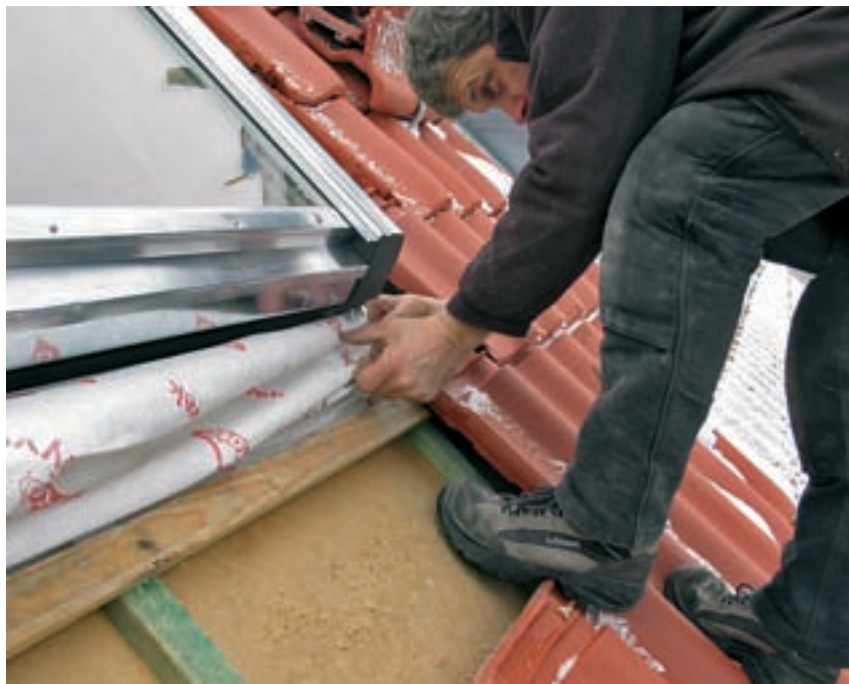
18. Unele dintre operațiuni sunt valabile și pentru montarea ferestrelor de la coama acoperișului. Astfel, cadrul ferestrei și blocul termoizolant montat în prealabil trebuie etanșate perimetral la vânt cu folie adezivă.
