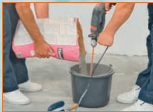
17. Prepararea șapei autonivelante se face în mod mecanic, chiar și într-o găleată de plastic.
