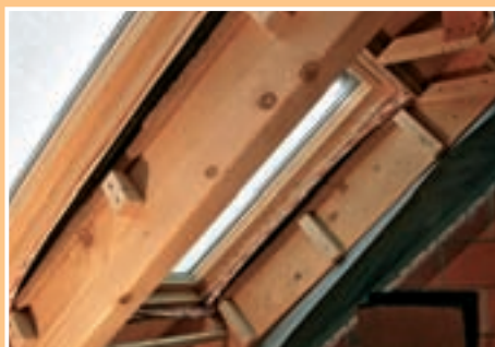
Pregătiri pentru termoizolarea intradosului: bucățelele din lemn vor susține ulterior panourile dinspre interior, respectiv materialul de umplutură.
