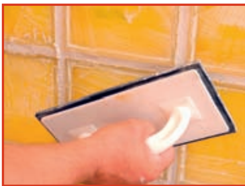
22. Rosturile sunt acoperite cu un chit special ce poate fi aplicat cu o gletieră de cauciuc.
