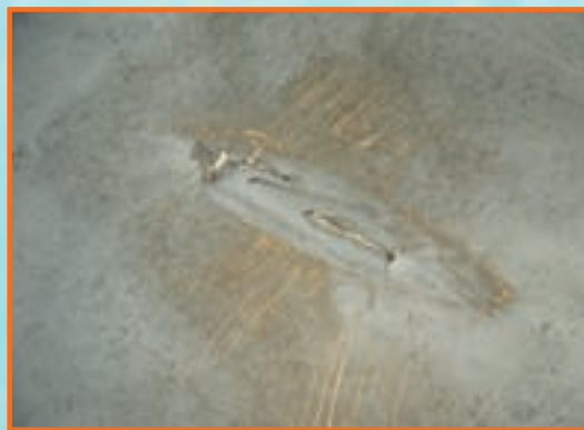
15. Dacă pardoseala are multe imperfecțiuni, acestea se vor rectifica cu un mortar special pentru reparații.
