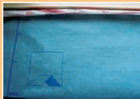
Bariera de vapor din carton armat se aplică pe suprafața înclinată a acoperișului de sub ferestre, continuând-o apoi în sus, până la cadrul acestora.
