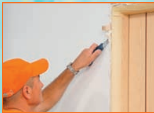
11. Până la uscarea pasteii, se poate trece la îndepărtarea surplusului de spumă poliuretanică din jurul tocului.
