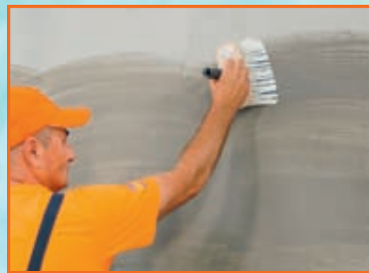
6. Amorsa se poate aplica cu pensula sau cu bidineaua și are nevoie de aproximativ 3 ore pentru a se usca.
