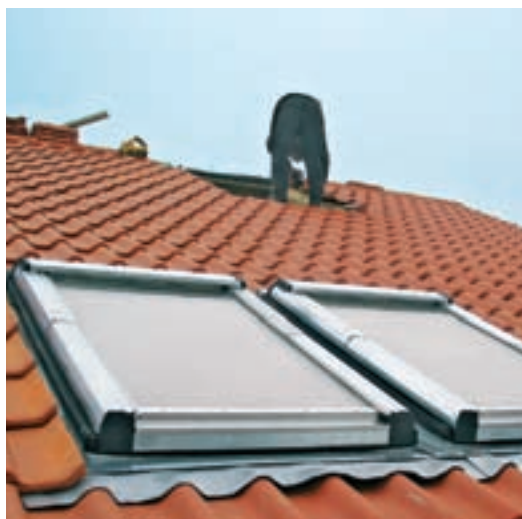
17. Iată cum arată fereastra dublă finalizată și integrată în acoperișul refăcut. Tabla de plumb e ajustată pe forma vălurită a țiglelor, cu mâna sau cu o bucată de material.
