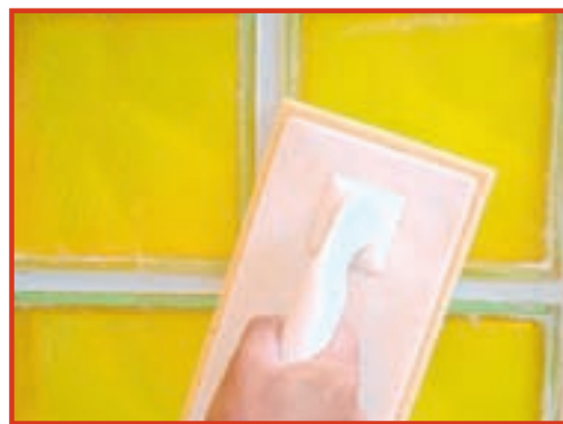
23. La final, se spală cu buretele umezit. Nu am folosit apă în exces, pentru a evita deteriorarea adezivului.
