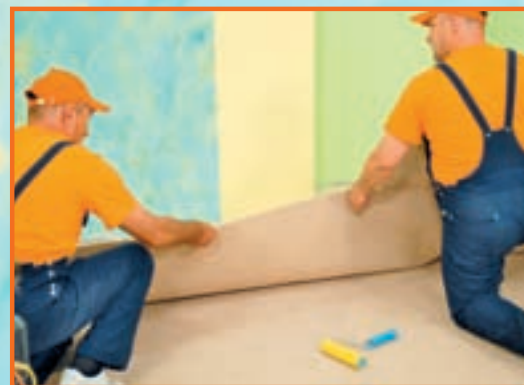
25. Peste soluția de lipit proaspăt aplicată am întins mocheta. O mână de ajutor a fost bine-venită.
