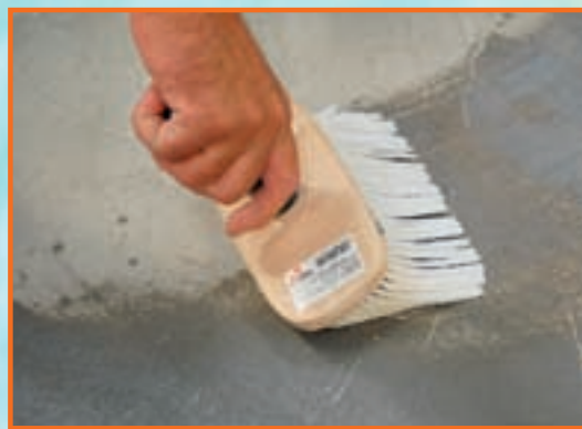
14. Amorsa se aplică nediluată, pe întreaga suprafață. Cel mai bun sistem de aplicare este cu o bidinea.
