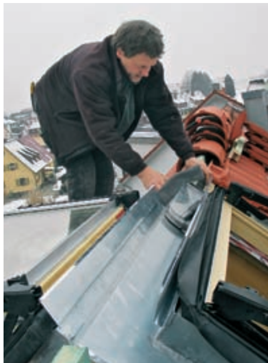
22. Înaintea refacerii coamei în forma inițială cu țigle specifice, pe tablă sunt lipite niște bucăți din material spongios cu rol de protecție împotriva zăpezii viscolite și aver-selor de ploaie. Acoperișul e din nou complet funcțional, dar modificat astfel contribuie simțitor la îmbunătățirea calității iluminatului natural în spațiul locuibil de dedesubt.
