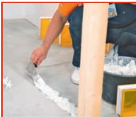
17. Am început cu aplicarea stratului de adeziv peste care se va așeza primul rând de cărămizi.
