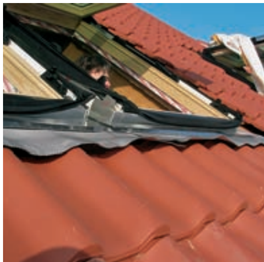
13. Ramele de acoperire se montează de jos în sus (mai întâi una sub fiecare fereastră, apoi câte două în lateralele acestora, prin suprapunere parțială peste prima).
