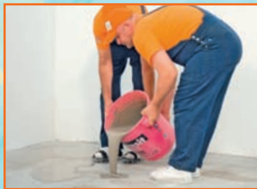
18. Șapa se toarnă în fâșii de 25-30 cm, după care se așteaptă producerea autonivelării.
