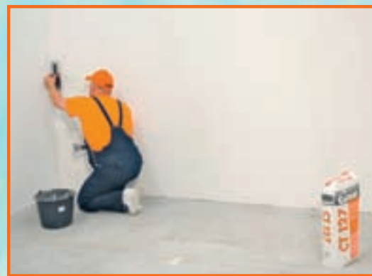
12. Următoarea peliculă de glet poate fi aplicată abia după ce s-a constatat uscarea primului strat.
