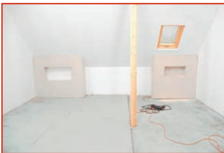
9. Operațiunea se repetă și în cazul construcției de gips-carton alăturate, rezultând o amenajare relativ simetrică.
