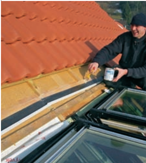
12. Deasupra ferestrelor, au fost înșurubate elemente din tablă dispuse în pantă înspre exterior. Ele contracarează acumularea apei pluviale pe astereală.
