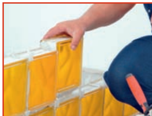
21. Așezarea perfect verticală a cărămizilor este esențială pentru rezistența în timp a zidului de sticlă.
