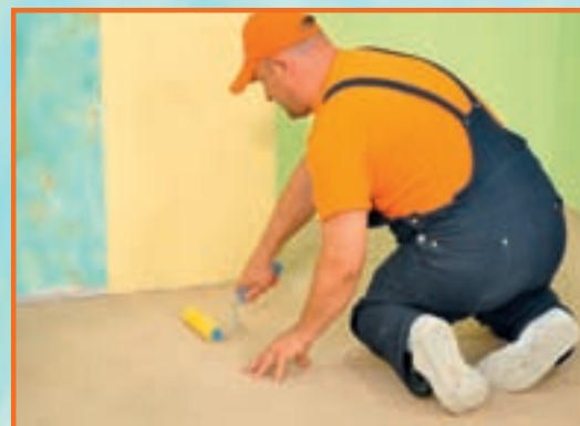
26. Pentru a nu forma cute, mocheta se întinde cu o rolă de cauciuc. Suprafața devine circulabilă în 4 ore.
