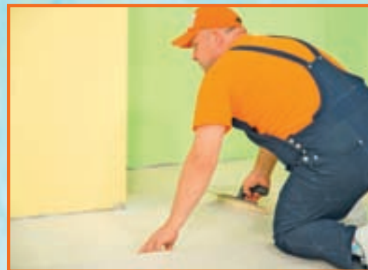
24. Cum șapa este destul de uscată pentru a continua amenajarea, am început aplicarea adevizului.
