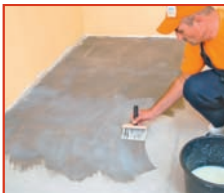
24. Pardoseala nu avea denivelări, deci nu am mai turnat șapă. Totuși, a fost necesară o amorsă.
