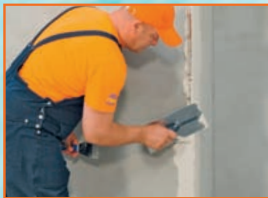
9. Fixarea profilelor din aluminiu va asigura colțuri perfecte drepte, rezistente la loviri și modificări structurale.
