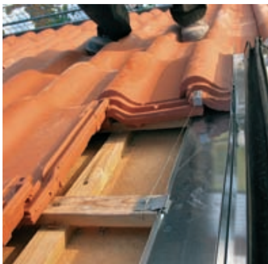
16. Vedere asupra modului de prindere a țiglelor. Cele înguste obținute prin decupare sunt alăturate ferestrelor, fiind prinse de șipca cea mai apropiată cu sârme și cleme.
