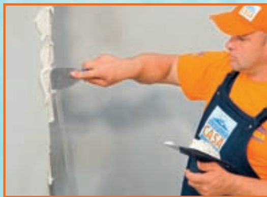
7. Gletuirea începe de la colțuri. Primul strat de pastă acționează ca un adevărat adeziv pentru profile.
