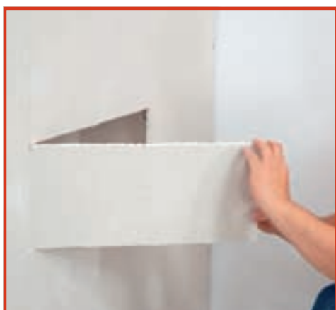
8. S-a eliminat cu ușurință fragmentul de gips-carton, rezultând un dreptunghi perfect.
