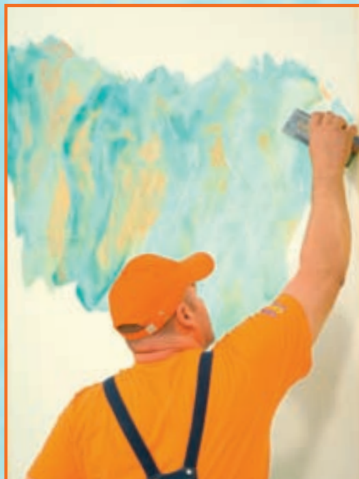
23. Pe o mică suprafață a unuia dintre pereți, am aplicat un sistem decorativ numit „dimineață cețoasă”.
