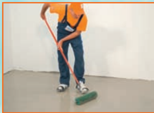
20. Șapa proaspăt turnată va trebui dezaerată cu ajutorul rolei cu țepi. Pardoseala devine circulabilă în 3 ore.
