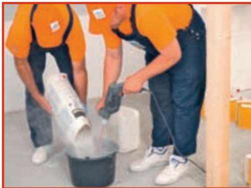
15. Mortarul-adeziv se prepară corect în mod meca-nic, respectându-se indicațiile producătorului.
