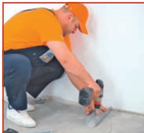
4. În continuare, au fost montate elementele metalice în pardoseală, cu șuruburi pentru beton.
