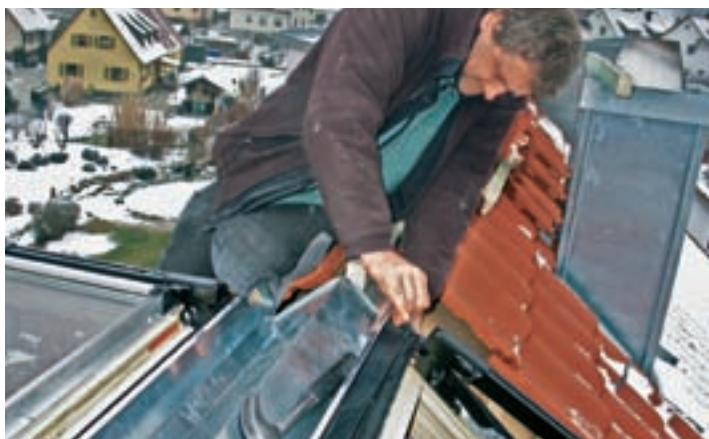
21. Elementele din tablă au fost fixate cu bride și cuie în șipcile de susținere. Marginea lor superioară este acoperită cu un cheder de etanșare din cauciuc.
