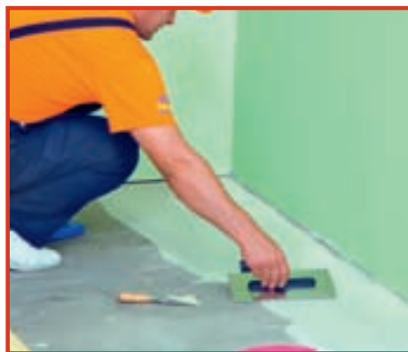
28. Soluția de lipit se întinde cu ajutorul unei glețiere metalice cu dinți de dimensiuni reduse.
