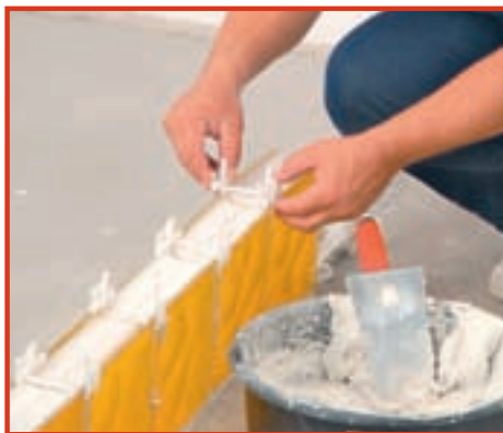
18. Dacă marginile cărămizilor sunt drepte, pot fi folosite distanțiere de 4 mm (cele mai mici).
