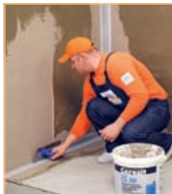
9. Se trece la izolarea întregului spațiu din jurul viitoarei căzi.
