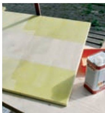
28. După uscarea și șlefuirea zonelor băluite, ele vor fi acoperite cu două straturi de lac.
