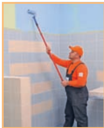
29. Vopseaua lavabilă va acționa și ca o barieră contra umezelii.
