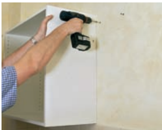
37. E rândul montajului corpurilor suspendate (dulapuri-lor) și a consolelor suport. În momentul fixării lor în zid, piesele de mobilier mai pot fi ajustate puțin.
