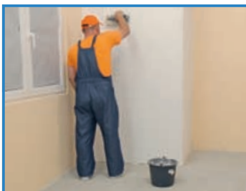
5. După uscarea primului strat, se poate aplica a doua peliculă de finisaj, de consistență redusă.
