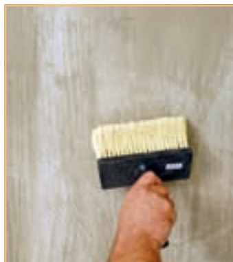
1. Pereții din zona căzii sunt amorsați cu un grund de profunzime.
