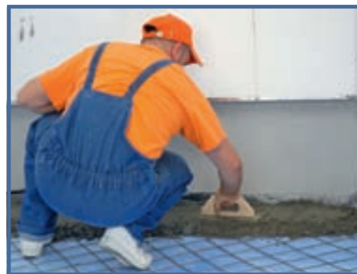
13 ... o șapă care va proteja sistemul prin redistribuirea sarcinilor, inerente teraselor circulare.
