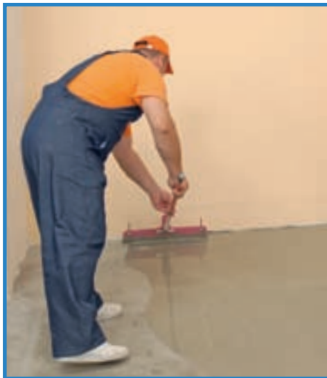
12. Nivelarea trebuie să vizeze întreaga suprafață, inclusiv marginile și colțurile.
