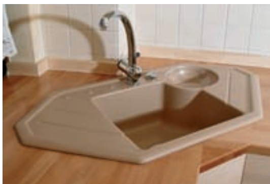
35. Chiuveta e fixată deja cu cleme sub blatul de lucru. S-a finalizat și umplerea cu silicon a rosturilor de racord dintre perete (respectiv blat) și profilele de protecție.
