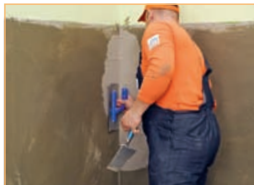
6. Și zonele de îmbinare verticale au fost tratate cu material hidroizolant, aplicat cu gletiera.
