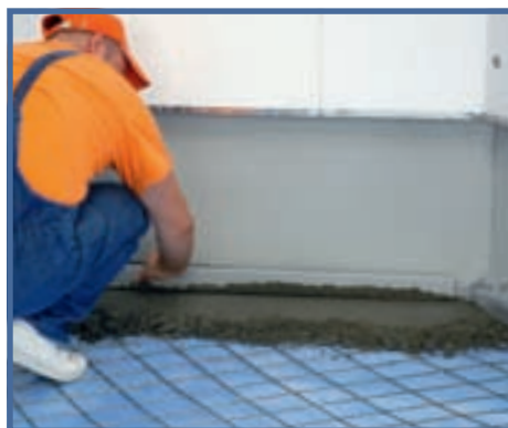
15 Plasa metalică flexibilă va asigura rezistența întregului ansamblu.
