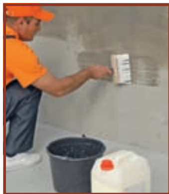
20. Echipa de meseriași a trecut la amorsarea pereților tencuiți.
