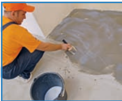
9. Planșeul a necesitat grunduire, pentru fixarea prafului rămas, cu un produs aplicat nediluat.
