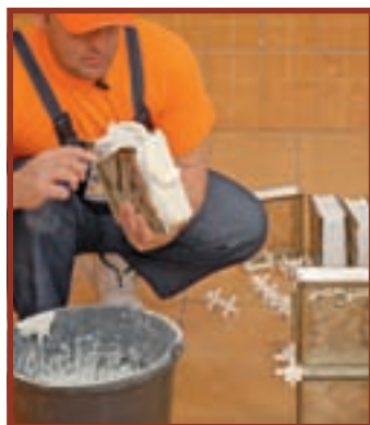
35. Mortarul se aplică pe marginile exterioare ale pieselor.
