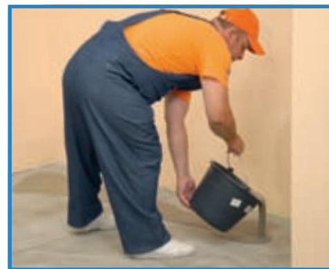
10. Cum pardoseala nu era perfect plană, a fost necesară turnarea unei șape autonivelante.
