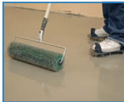
13. Dezaerarea mortarului se face fără a afecta plănitatea obținută anterior.
