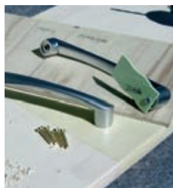
30. ...sunt montate adecvat, apoi se înșurubează mânerul cu feronerie aferentă pe suprafețele manevrabile.
