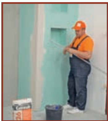
16. La fel s-a procedat și la finisarea scafelor, folosind colțare mai scurte.
