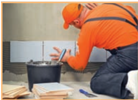
15. Primul rând de faianță este cel mai important; el este amplasat la aproximativ o lățime de placă de pardoseală.
