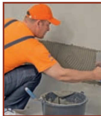
22. A urmat aplicarea adezivului la câțiva centimetri de pardoseală.
