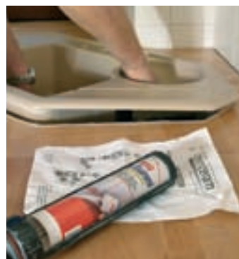
34. În final, noua chiuvetă de colț e montată în decupajul creat (se introduce pe verticală de sus în jos).
