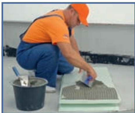
17 Acum este posibilă placarea soclului cu polistiren, după metoda cunoscută...
