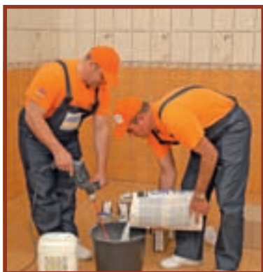
34. E timpul preparării adezivului pentru cărămizile de sticlă.
