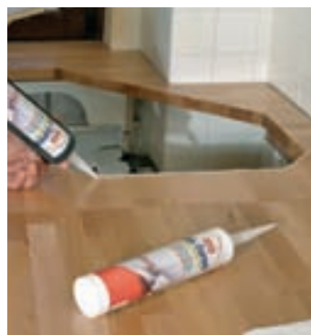
33. Toate muchiile de tăiere, inclusiv cele perimetrale din zona de reazem a chiuvetei, sunt etanșate cu silicon.
