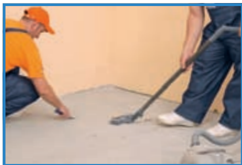
8. Obiectivul următor este pardoseala. Impuritățile de orice natură au fost îndepărtate și aspirate.
