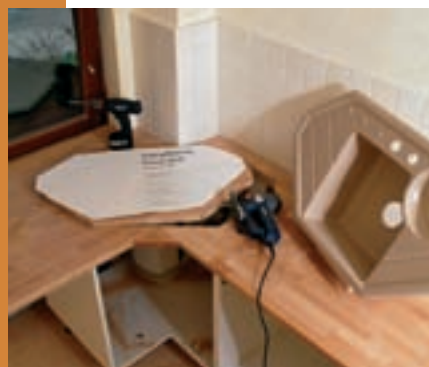
32. ... sunt finisate colțurile, pentru ca apoi să poată fi executat decupajul corespunzător chiuvetei.
