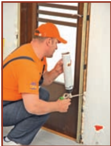
31. Fixarea finală a tocului s-a realizat cu spumă poliuretanică bicomponentă.
