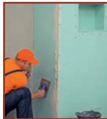
15. În gletul aplicat s-a înglobat colțarul din aluminiu.
