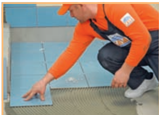
18. Aici au fost folosite plăci de dimensiuni mari (30x30 cm), despărțite de distanțiere de 3 mm.
