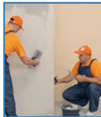
4. Finisarea completă a pereților continuă cu o gletuire uniformă.
