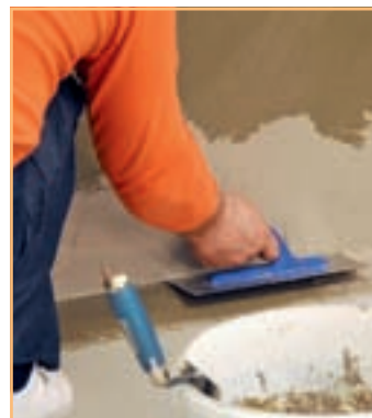
3. Al doilea strat se aplică în scurt timp, după uscarea primului.
