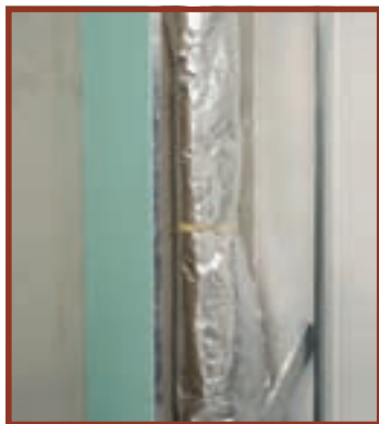
8. Pentru aceasta s-a folosit vată minerală cașerată (bazaltică).
