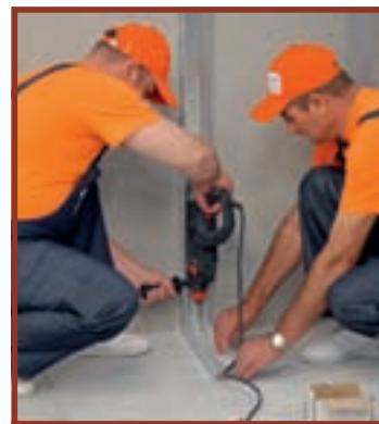
5. Sunt necesare găuri pentru fixarea cadrului în perete și pardoseală.
