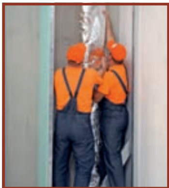
7. Înainte de a fi camuflate, țevile au beneficiat de termoizolație.
