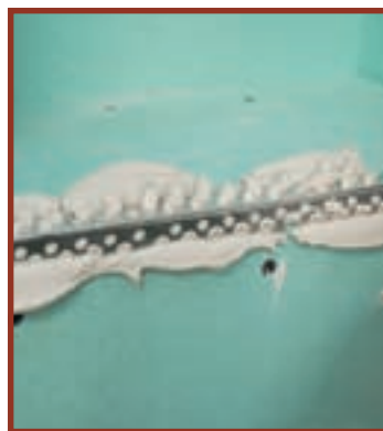
18. Imediat s-au montat profilele, înainte ca materialul să se întărească.
