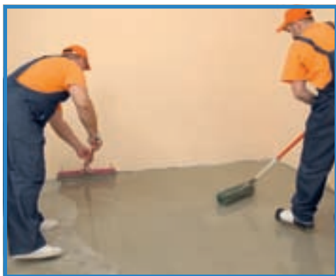
11. Pentru a nu se depăși timpul de punere în operă a șapei, se recomandă lucrul în echipă.
