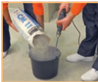
14. Placarea pereților cu faianță începe, desigur, cu prepararea adezivului.
