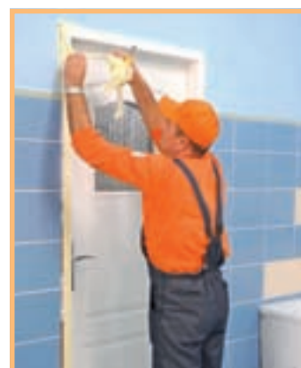
31. ... apoi a benzii adezive de protecție și lucrarea e gata!
