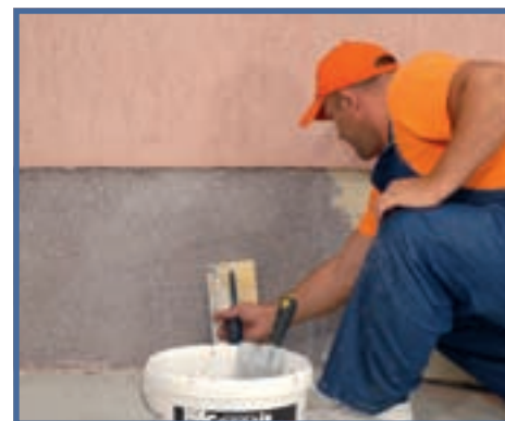
19 O tencuială decorativă, rezistentă la solicitări mecanice, completează sistemul.
