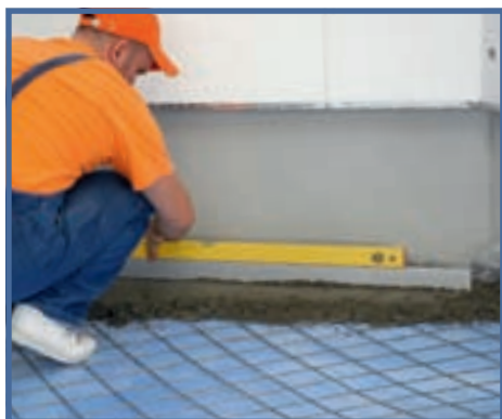
14 Se nivelează cu un dreptar, iar cu ajutorul polobocului se obține panta dorită.
