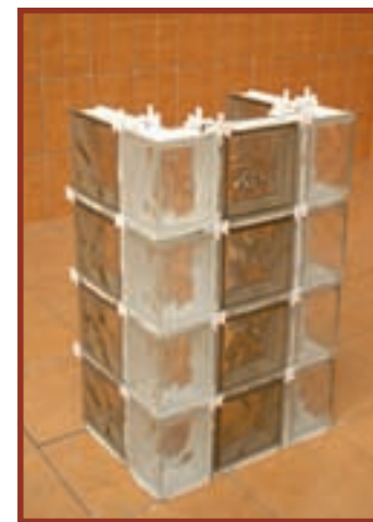
37. La rosturile de dilatație se folosesc doar distanțiere de plastic.
