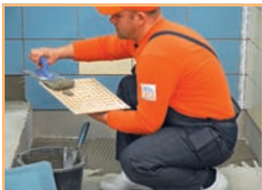
17. Se trece la montarea gresiei, un produs cu rezistență la abraziune corespunzătoare uzului casnic (PEI 2).
