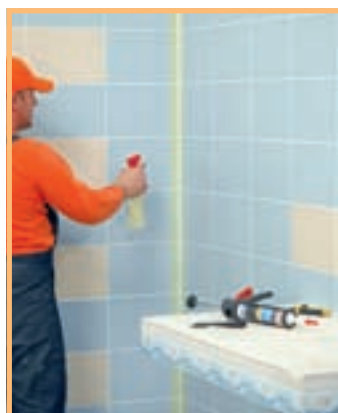
25. Peste silikonul proaspăt aplicat, se pulverizează iarăși apă...
