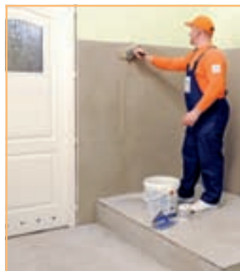
2. Primul strat de hidroizolație se aplică prin pensulare sau șpăcluire.
