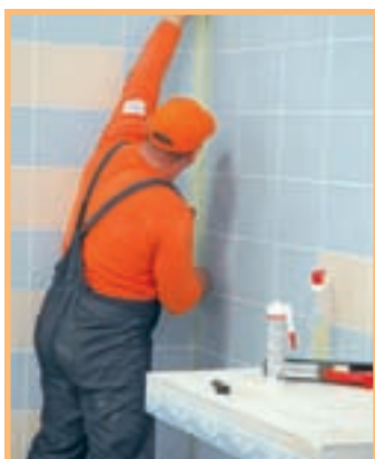
23. Zonele de îmbinare trebuie protejate cu bandă adezivă...
