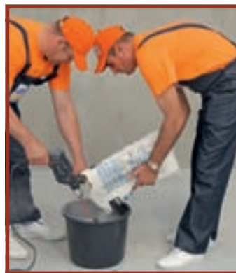
21. Prepararea adezivului s-a realizat mecanic, cu un mixer special.
