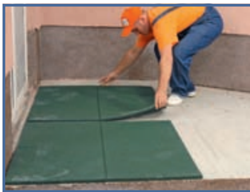
20 Stratul final constă în dale de cauciuc impermeabile, fonoizolante, de culoarea ierbii.
