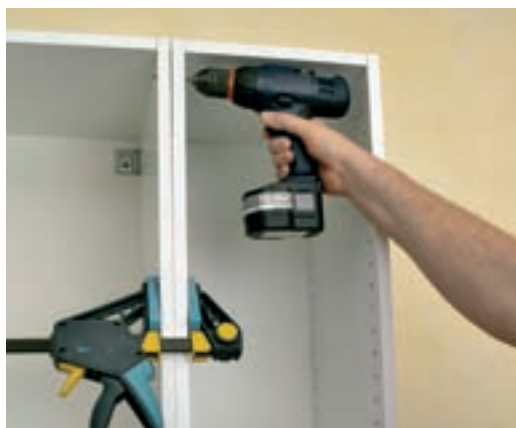
38. În vederea unei poziționări perfecte, modulele sunt fixate suplimentar între ele cu mici șuruburi ce pot fi introduse opțional la nivelul rafturilor (ascunse).
