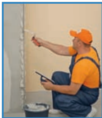
2. Peste gletul proaspăt aplicat, au fost montate colțarele din aluminiu.
