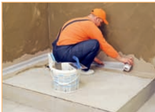
4. Pentru etanșare și pentru preluarea tensiunilor din zonă, se folosește o bandă cauciucată elastică.
