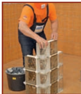
36. În cazul acesta, construcția din sticlă nu necesită armătură metalică.
