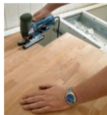
31. Plăcile blatului de lucru se așază pe dulapurile reinstalate la locul lor. Cu un ferăstrău pendular...
