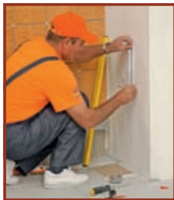
27. Prin această ușiță se pot executa reparații sau manipula robinetele.
