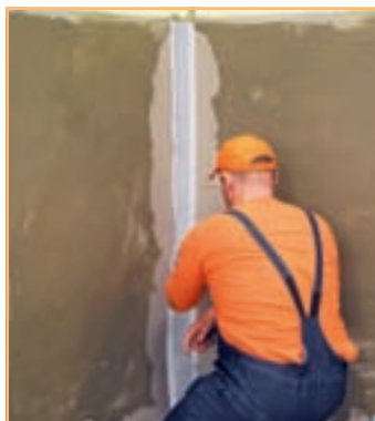
7. La acest nivel au fost montate, de asemenea, benzi de etanșare.
