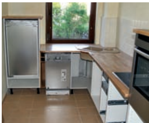
36. Iată starea intermediară a lucrărilor de montaj: dulapurile de jos fără elemente frontale, blatul de lucru, chiuveta și aparatura electrocasnică la locul stabilit.
