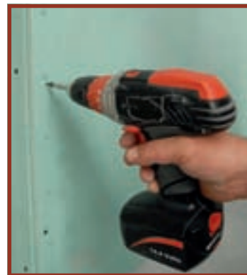
10. Șuruburile au fost introduse cu ajutorul șurubelniței cu acumulator.
