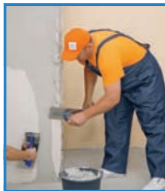
3. Pentru a fixa elementele metalice, se netezește gletul ieșit prin orificii.
