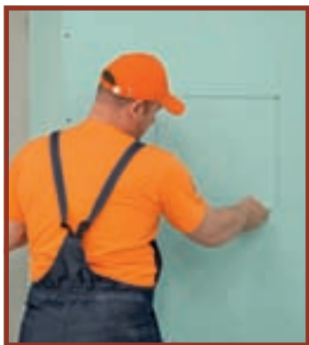
12. În construcția de gips-carton s-au făcut decupaje dreptunghiulare...
