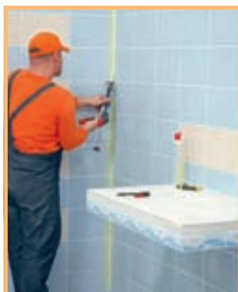
24. ... și tratate cu silikon sanitar, un material elastic, antimucegai.
