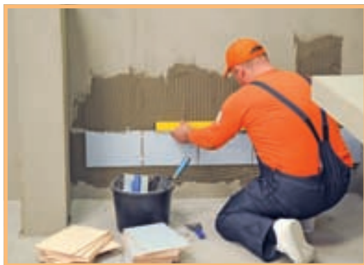
16. În același timp, se verifică orizontalitatea primului rând, indiferent de planeitatea pereților și podelei.
