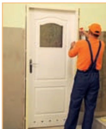
12. Se pulverizează apă și se aplică o spumă aderentă la suport...
