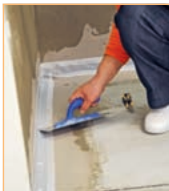
5. Banda se înglobează în materialul hidroizolant folosit anterior.
